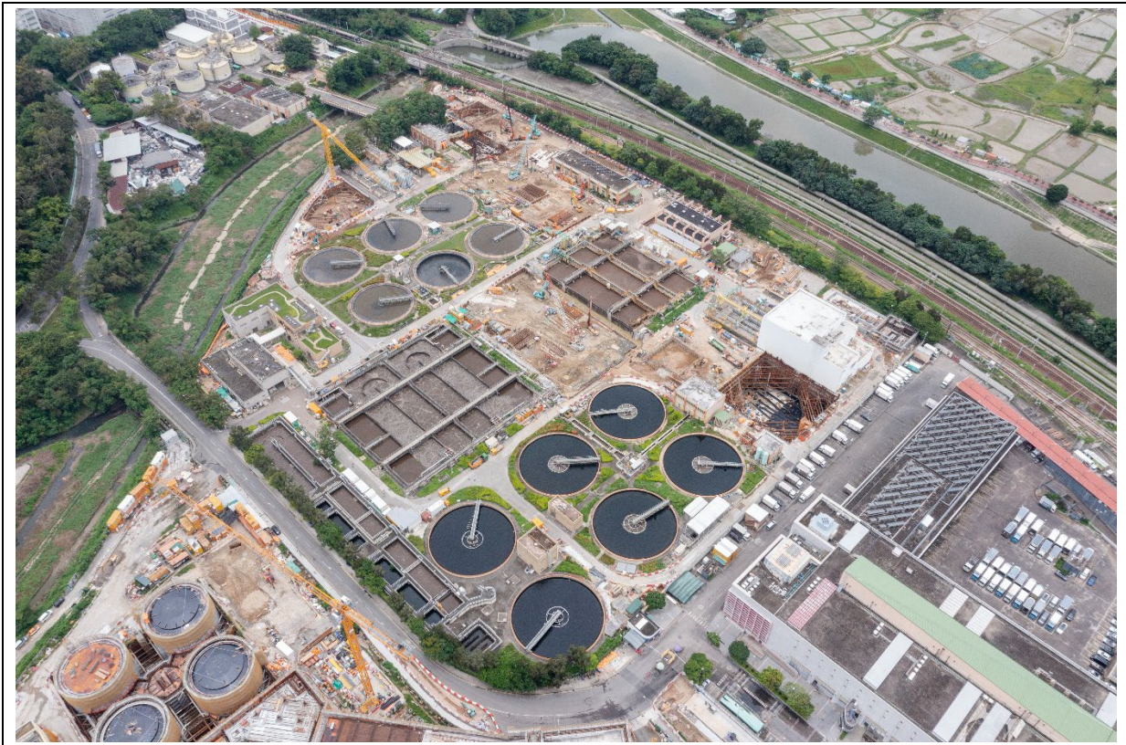
描述： 工地甲部分及乙部分的1号航拍照片 (拍摄于2022年6月20日)
