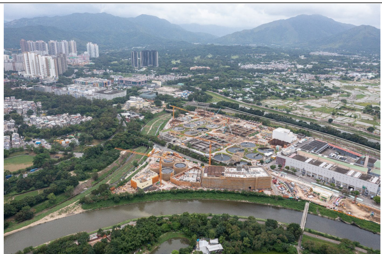
描述： 工地丙部分的1号航拍照片 (拍摄于2022年6月20日)
