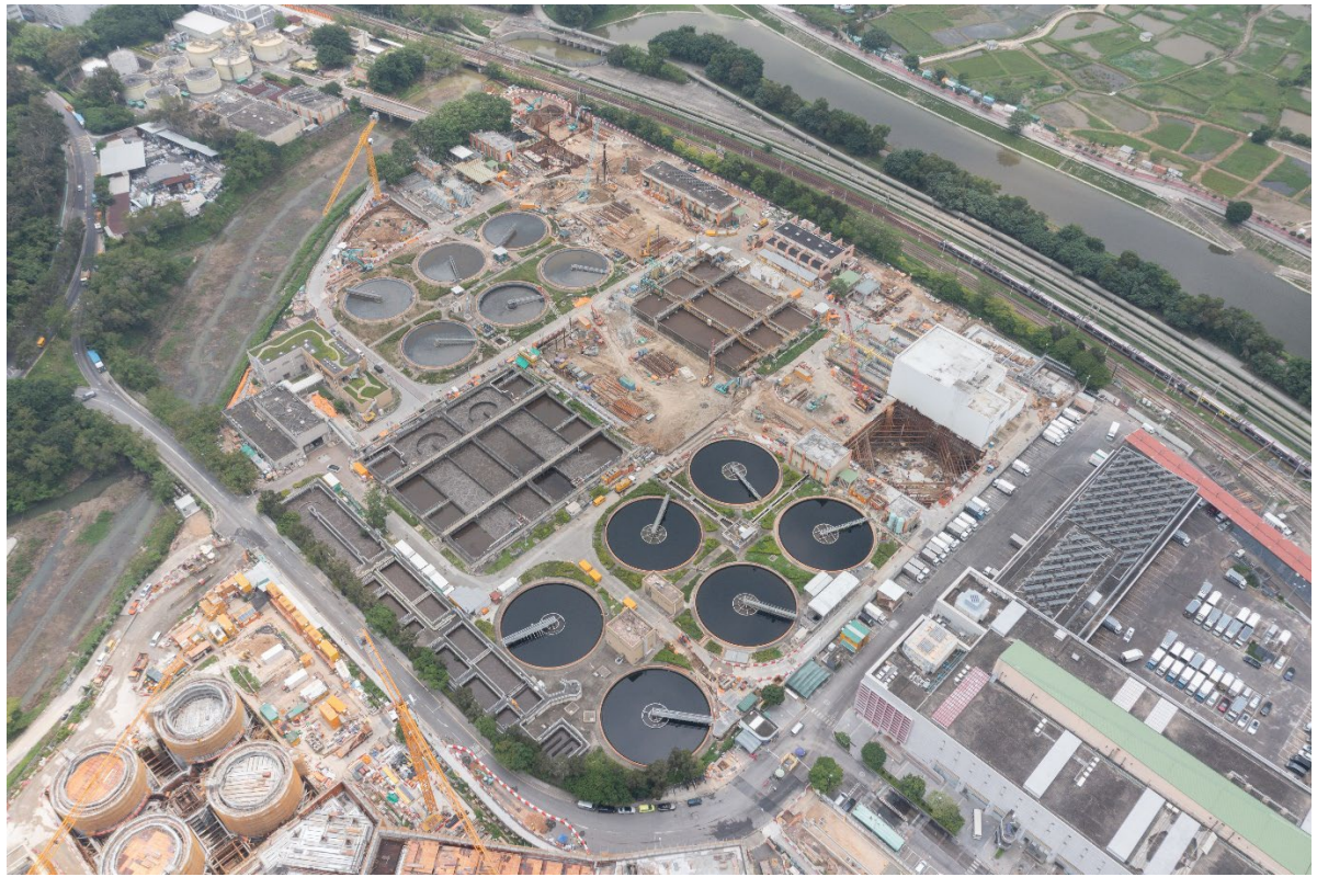
描述： 工地甲部分及乙部分的1號航拍照片 (拍攝於2022年5月22日)
