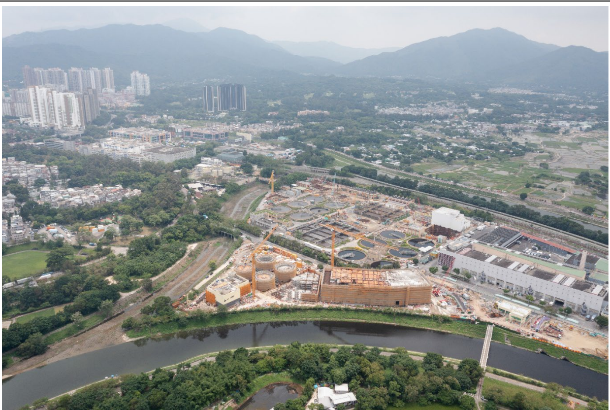
描述： 工地丙部分的1號航拍照片 (拍攝於2022年5月22日)
