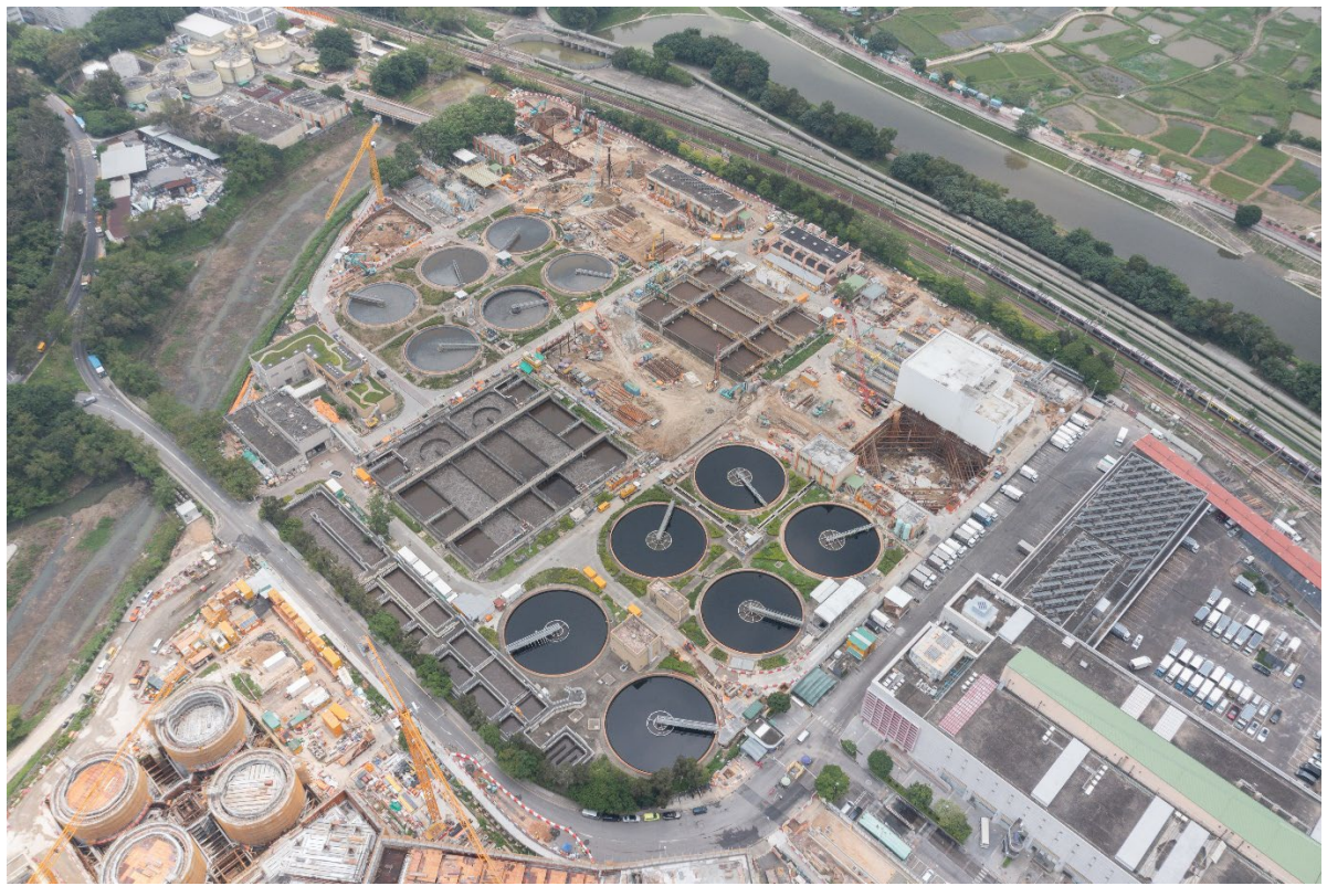
描述： 工地甲部分及乙部分的1号航拍照片 (拍摄于2022年5月22日)
