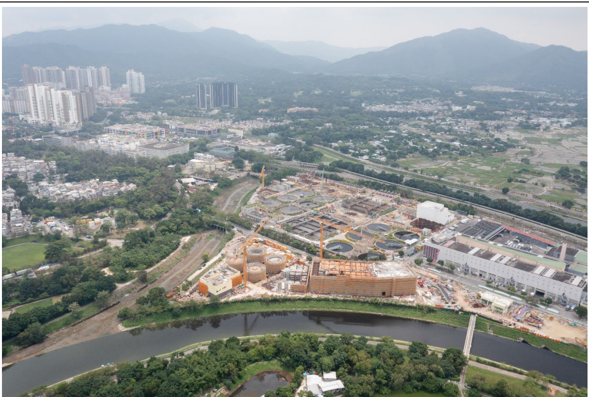
描述： 工地丙部分的1号航拍照片 (拍摄于2022年5月22日)
