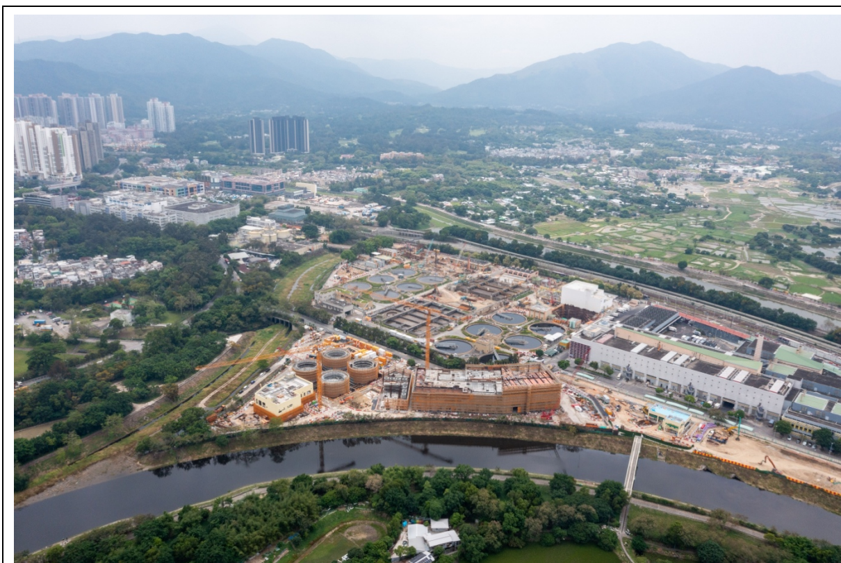
描述: 工地丙部分的1號航拍照片 (拍攝於2022年4月16日)
