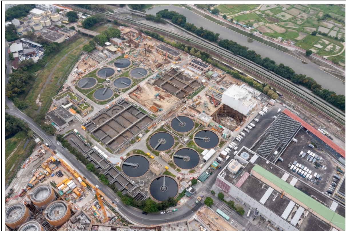
描述: 工地甲部分及乙部分的1號航拍照片 (拍攝於2022年4月16日)
