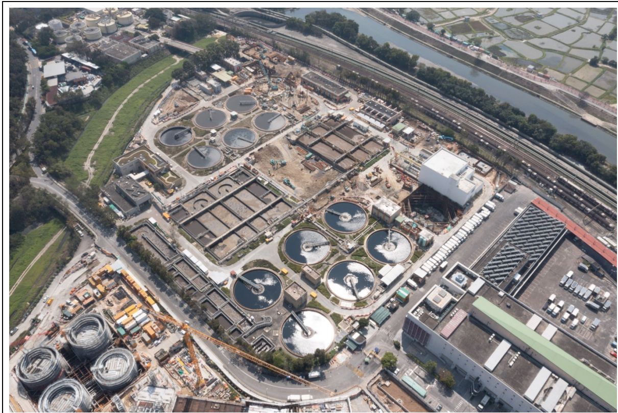
描述: 工地甲部分及乙部分的1號航拍照片 (拍攝於2022年2月16日)
