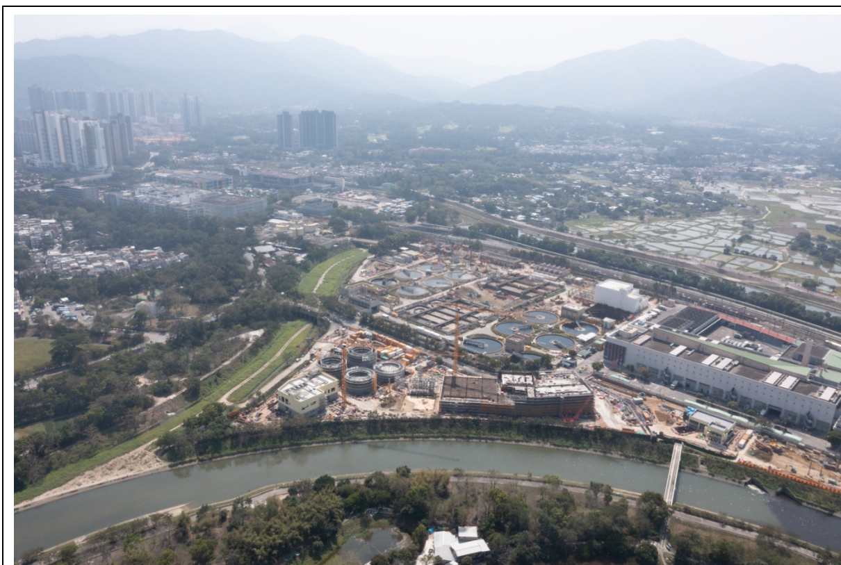
描述: 工地丙部分的1號航拍照片 (拍攝於2022年2月16日)
