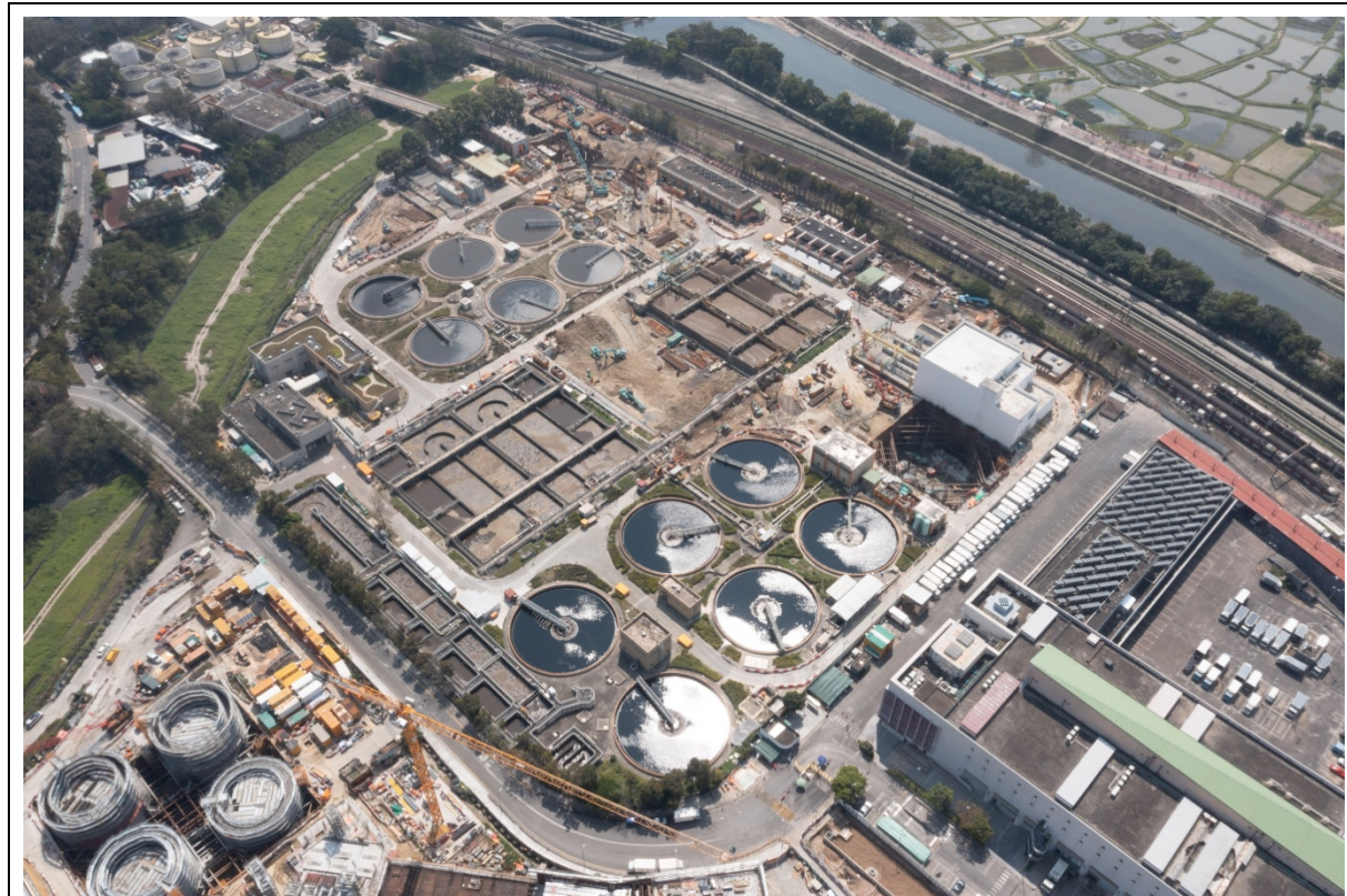
描述: 工地甲部分及乙部分的1号航拍照片 (拍摄于2022年2月16日)
