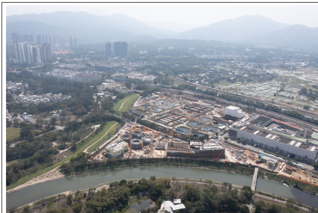
描述: 工地丙部分的1号航拍照片 (拍摄于2022年2月16日)
