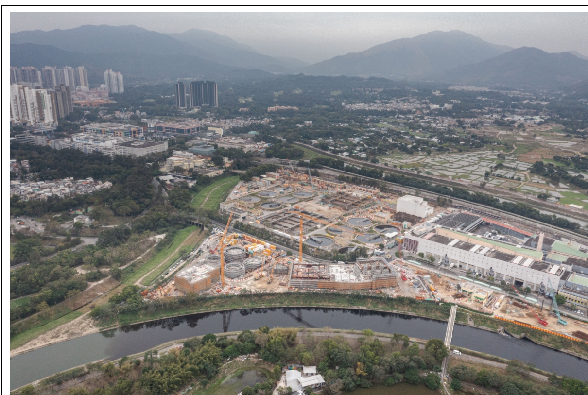
描述: 工地丙部分的1號航拍照片 (拍攝於2022年1月16日)
