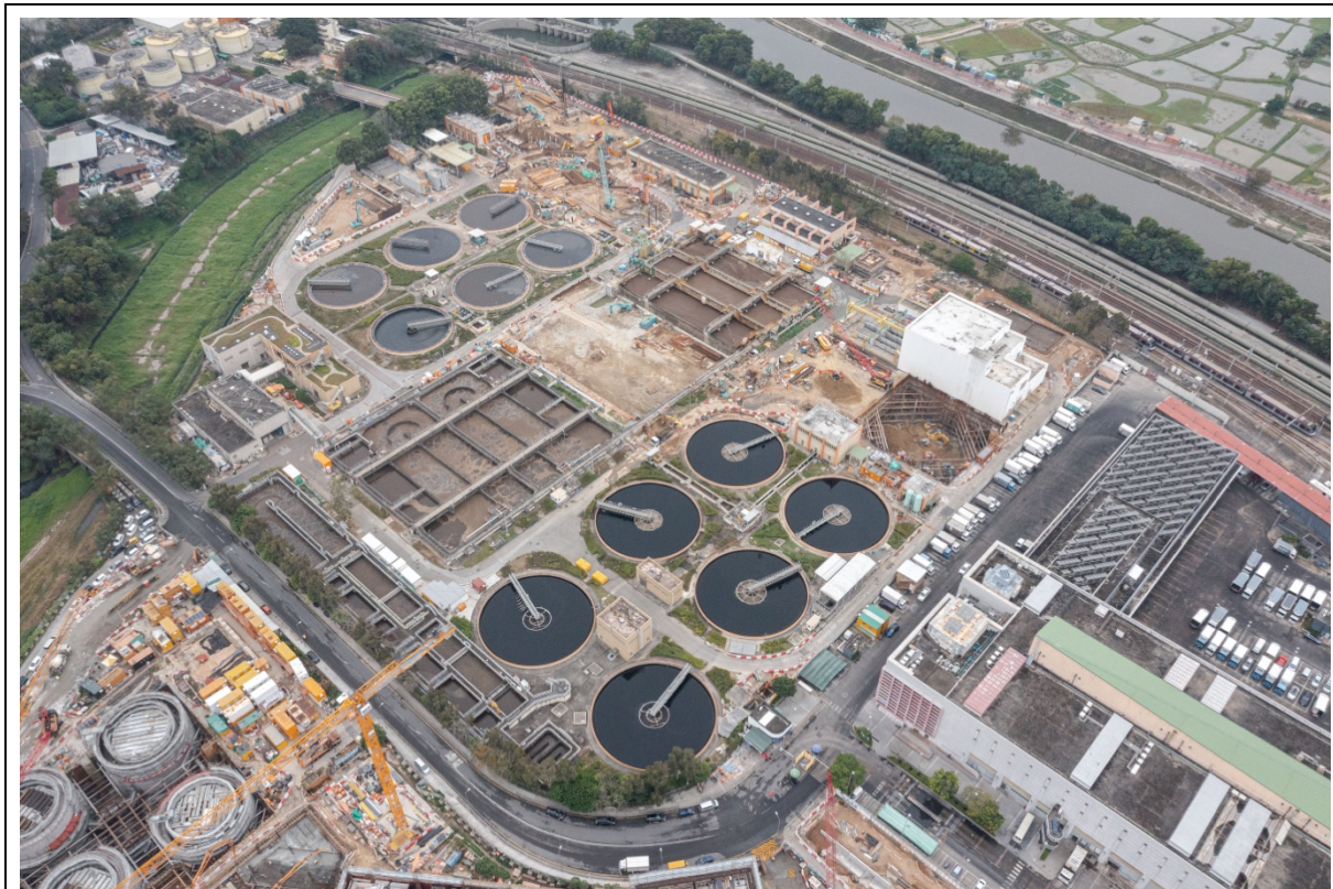
描述: 工地甲部分及乙部分的1號航拍照片 (拍攝於2022年1月16日)
