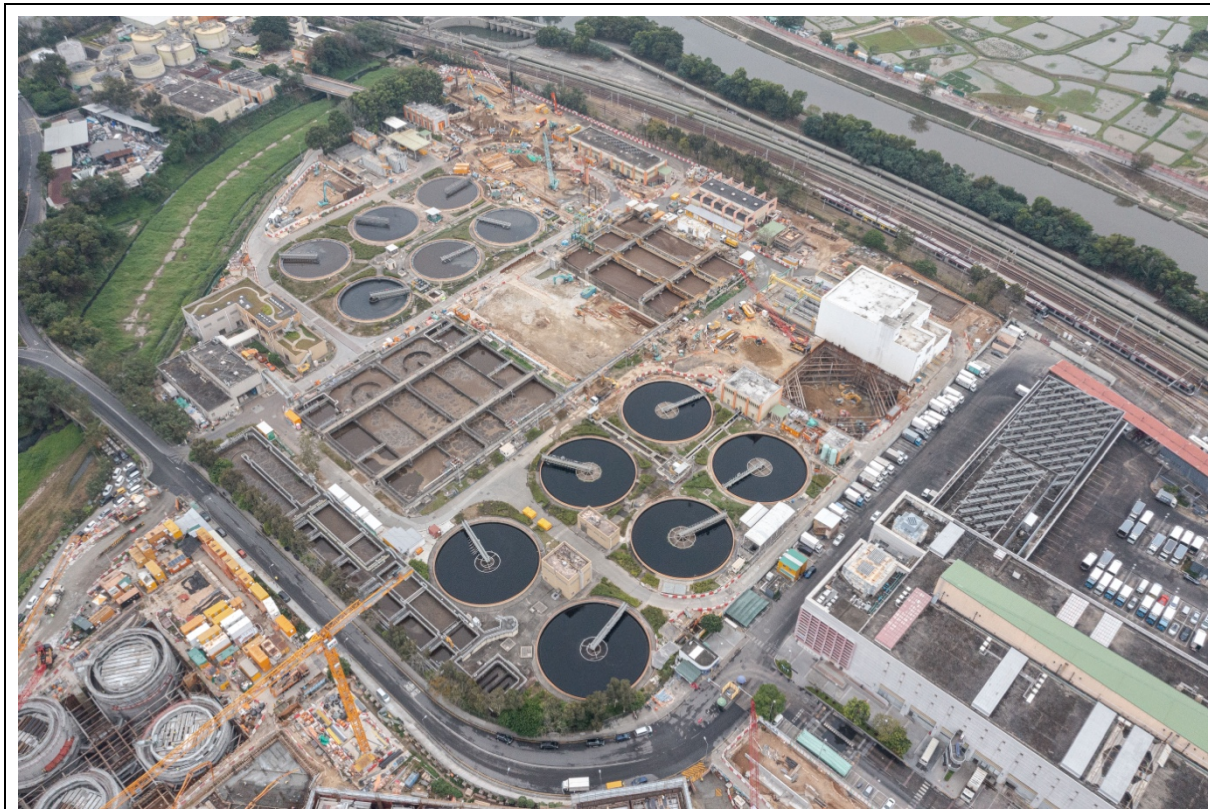
描述: 工地甲部分及乙部分的1号航拍照片 (拍摄于2022年1月16日)
