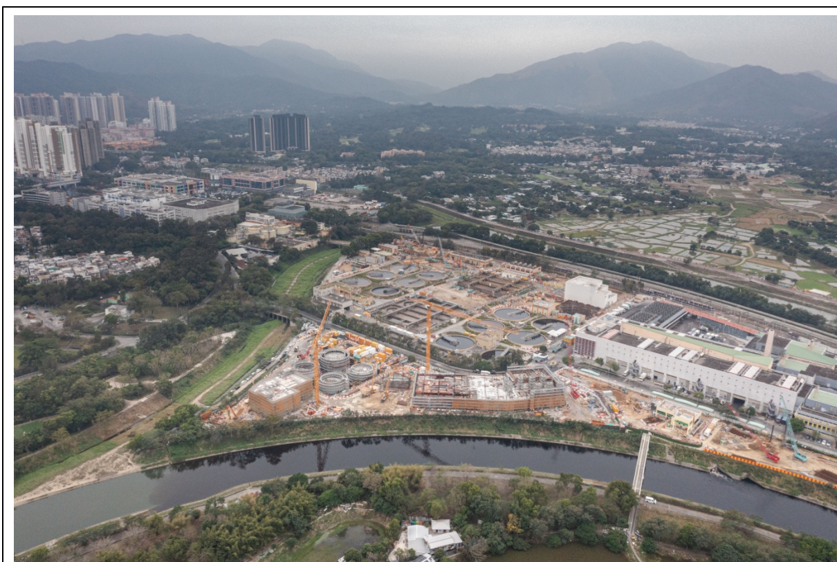
描述: 工地丙部分的1号航拍照片 (拍摄于2022年1月16日)
