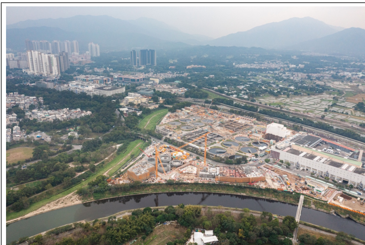
描述: 工地丙部分的1號航拍照片 (拍攝於2021年12月16日)
