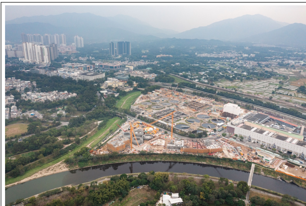
描述: 工地丙部分的1号航拍照片 (拍摄于2021年12月16日)
