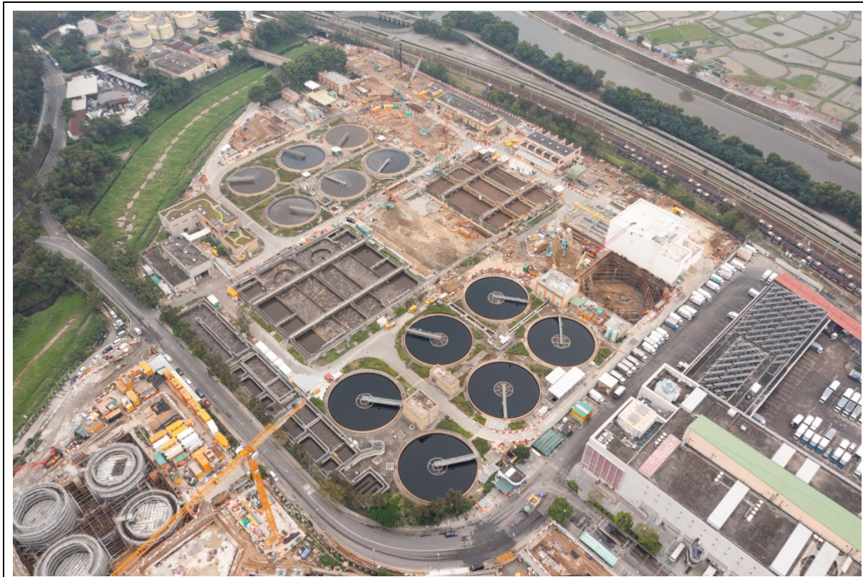
描述: 工地甲部分及乙部分的1号航拍照片 (拍摄于2021年12月16日)
