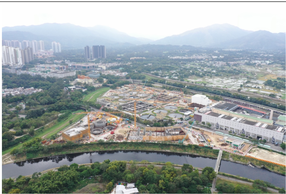
描述: 工地丙部分的1號航拍照片 (拍攝於2021年11月16日)
