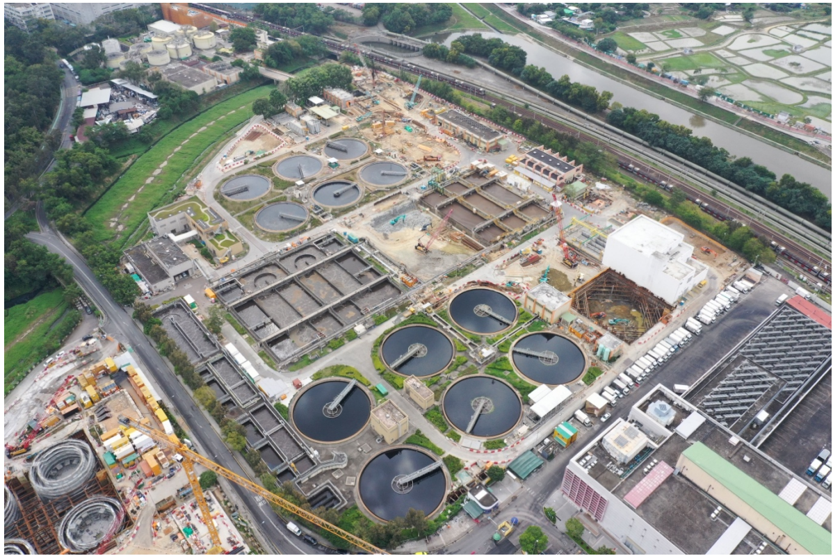
描述: 工地甲部分及乙部分的1號航拍照片 (拍攝於2021年11月16日)
