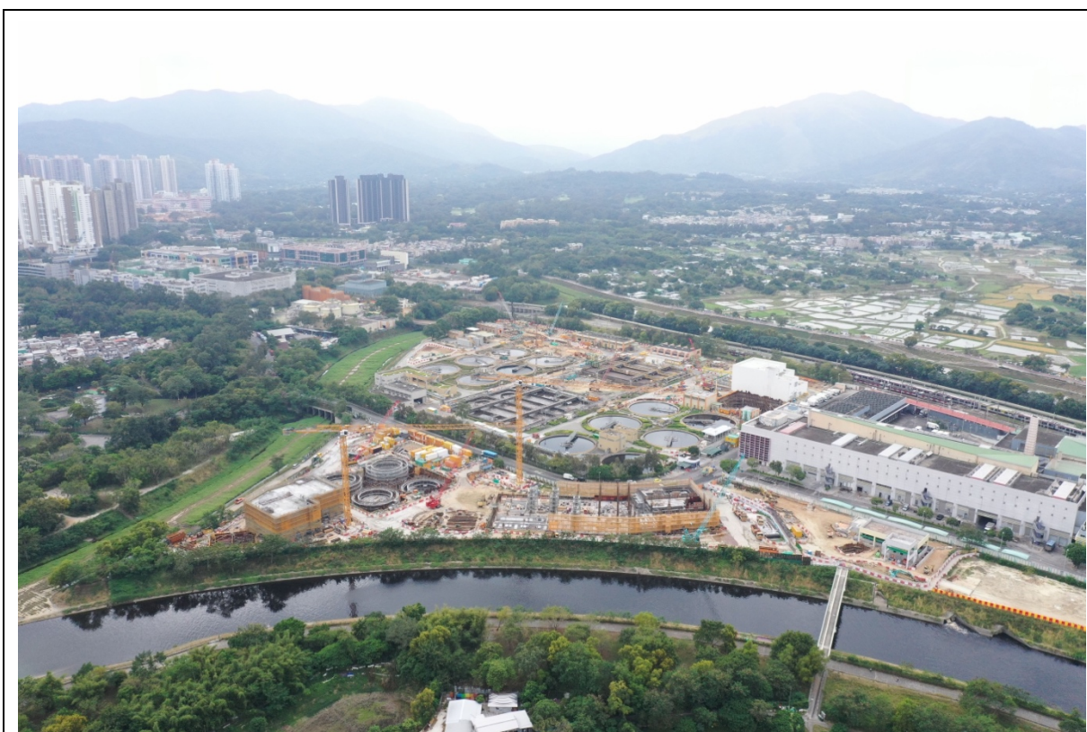
描述: 工地丙部分的1号航拍照片 (拍摄于2021年11月16日)
