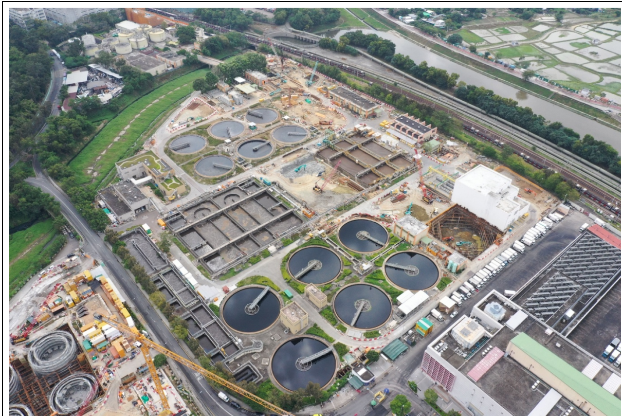
描述: 工地甲部分及乙部分的1号航拍照片 (拍摄于2021年11月16日)
