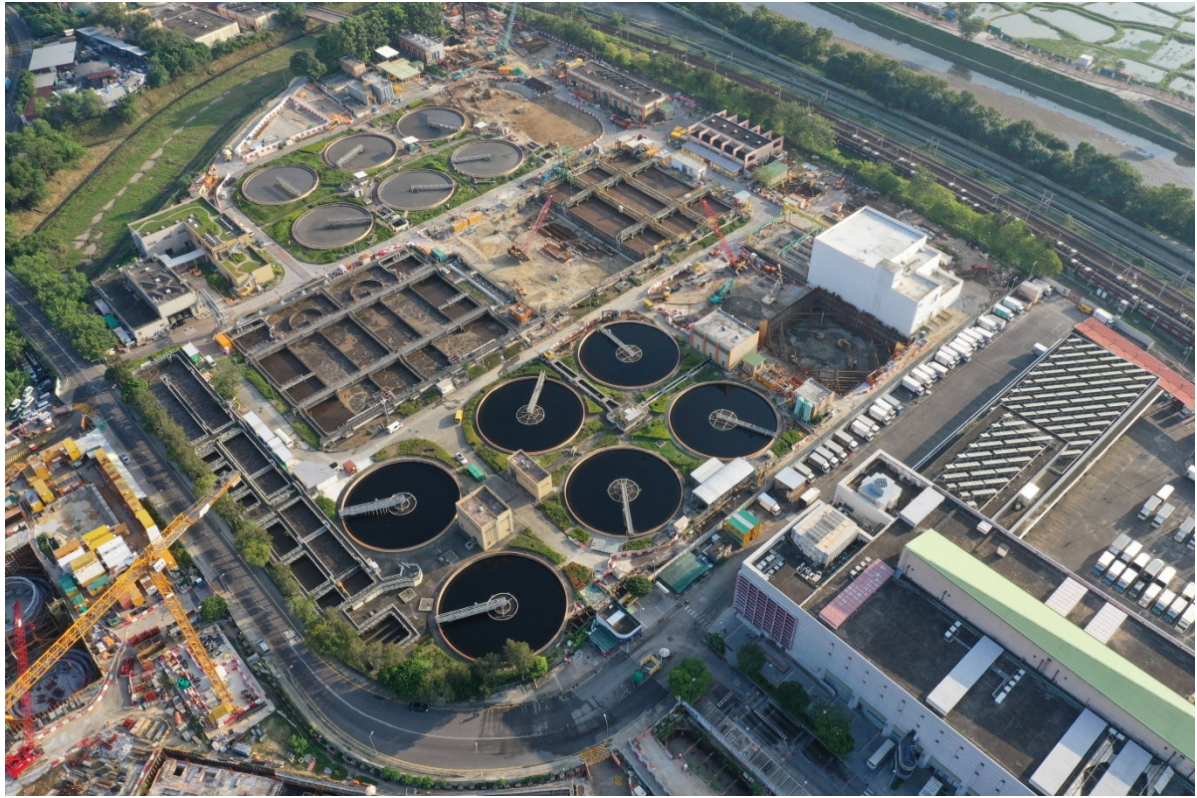
描述: 工地甲部分及乙部分的1號航拍照片 (拍攝於2021年10月16日)
