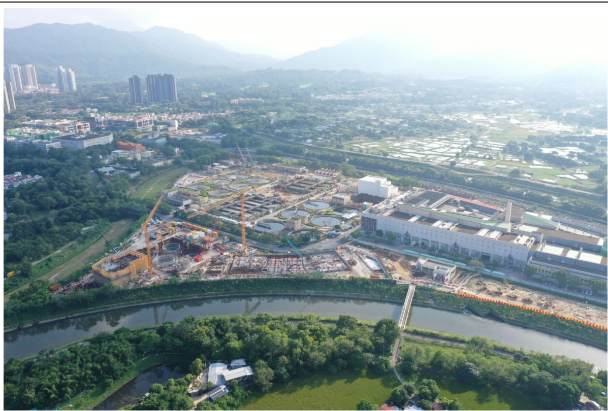
描述: 工地丙部分的1号航拍照片 (拍摄于2021年10月16日)
