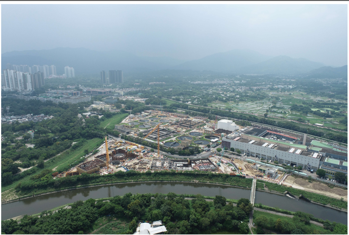
描述: 工地丙部分的1號航拍照片 (拍攝於2021年9月16日)
