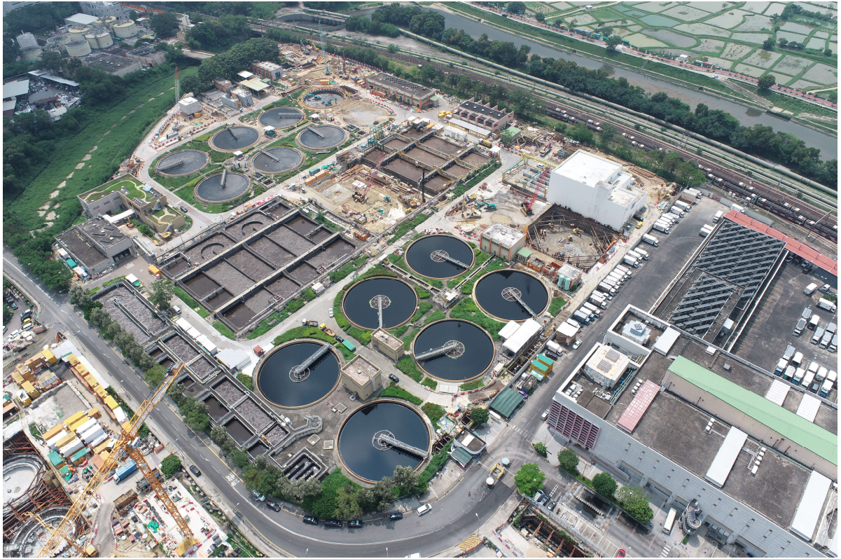
描述: 工地甲部分及乙部分的1號航拍照片 (拍攝於2021年9月16日)
