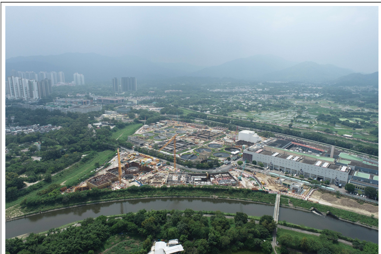
描述: 工地丙部分的1号航拍照片 (拍摄于2021年9月16日)
