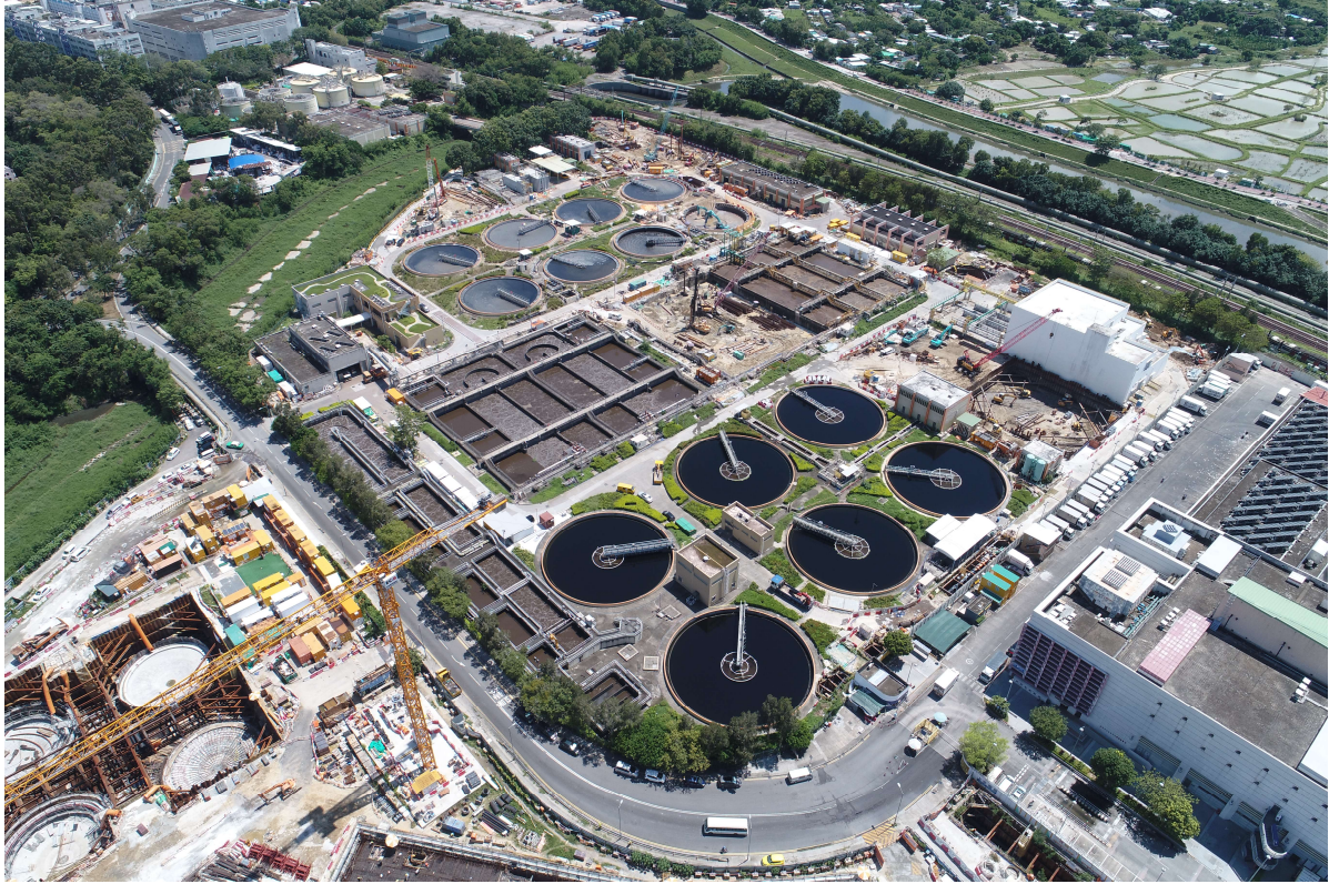
描述: 工地甲部分及乙部分的1號航拍照片 (拍攝於2021年8月20日)
