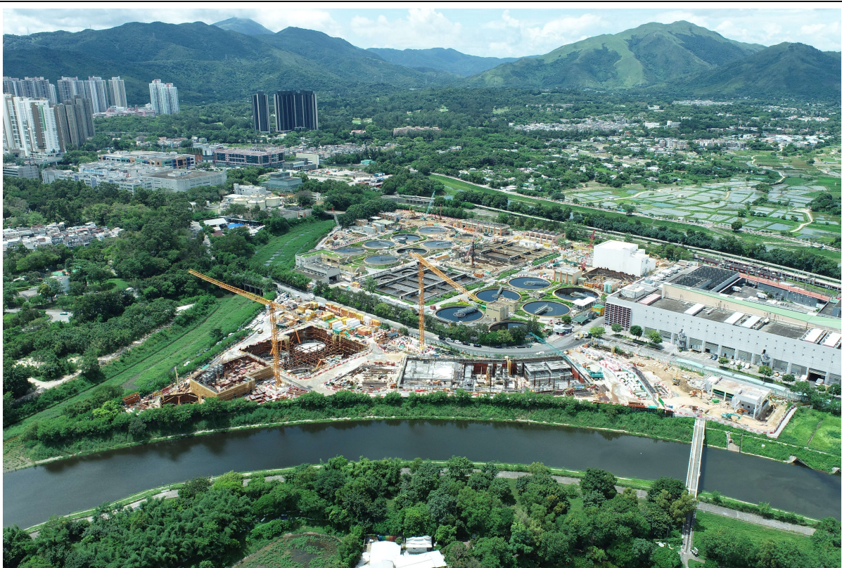
描述: 工地丙部分的1號航拍照片 (拍攝於2021年8月20日)
