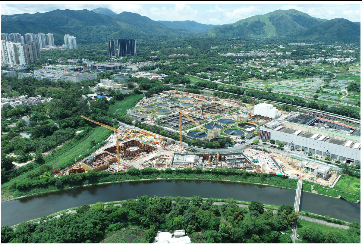
描述: 工地丙部分的1号航拍照片 (拍摄于2021年8月20日)
