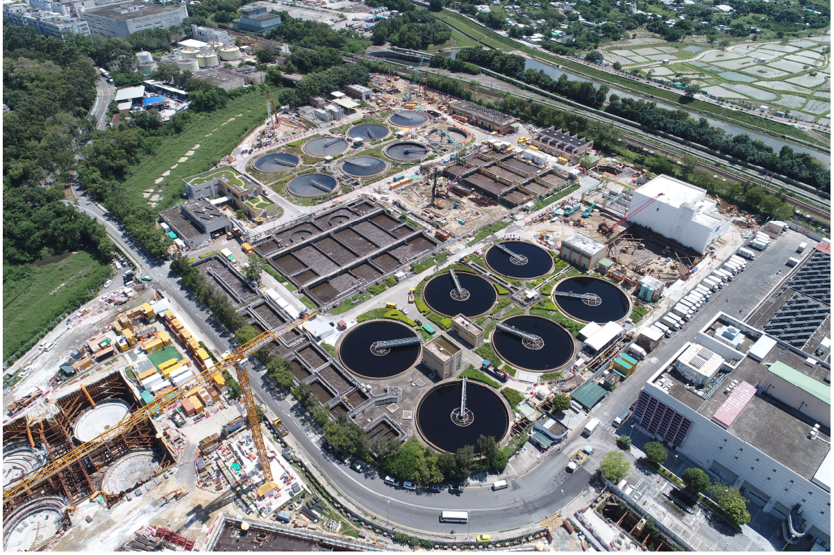
描述: 工地甲部分及乙部分的1号航拍照片 (拍摄于2021年8月20日)
