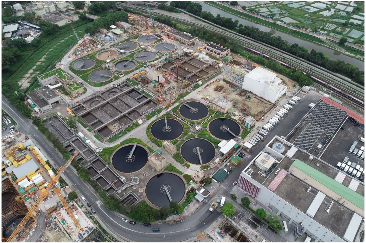
描述: 工地甲部分及乙部分的1號航拍照片 (拍攝於2021年7月25日)
