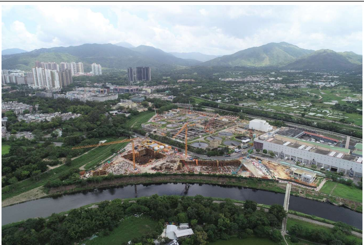
描述: 工地丙部分的1號航拍照片 (拍攝於2021年7月25日)
