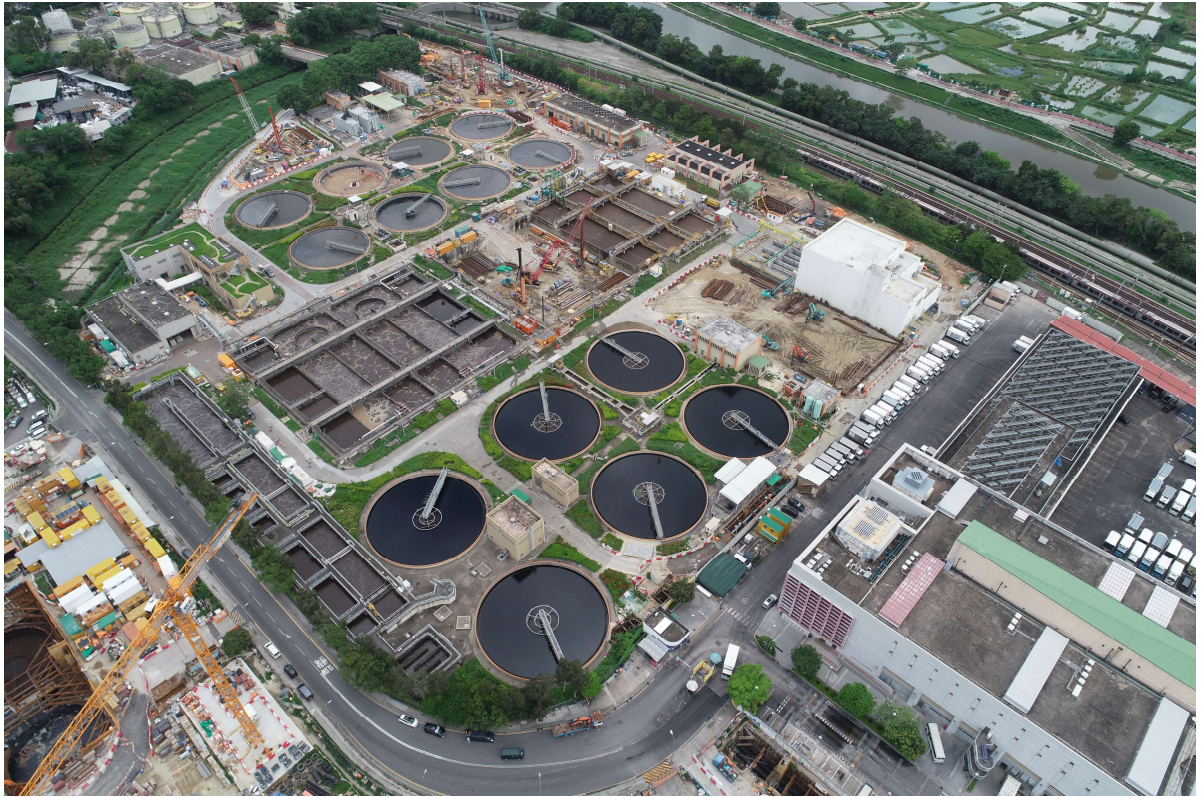
描述: 工地甲部分及乙部分的1號航拍照片 (拍攝於2021年6月22日)
