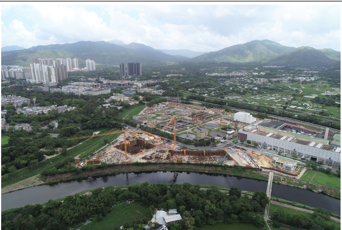
描述: 工地丙部分的1号航拍照片 (拍摄于2021年6月22日)
