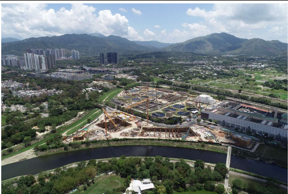
描述: 工地乙及丙部分的2号航拍照片 (拍摄于2021年5月18日)
