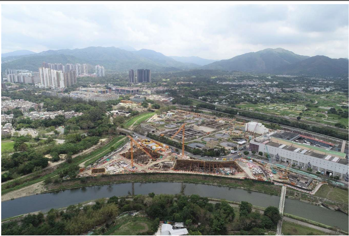
描述: 工地乙及丙部分的2号航拍照片 (拍摄于2021年4月12日)
