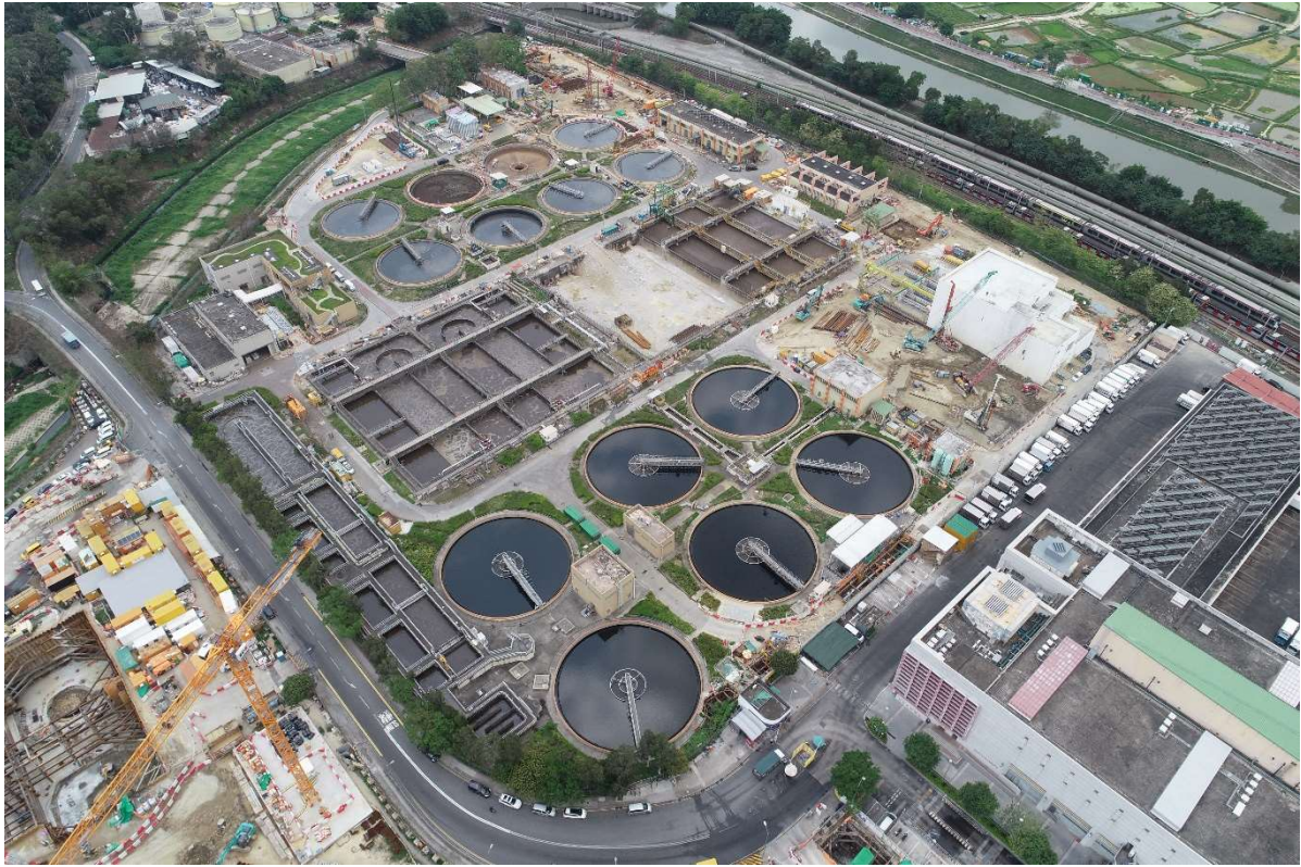
描述: 工地甲部分的1号航拍照片 (拍摄于2021年4月12日)
