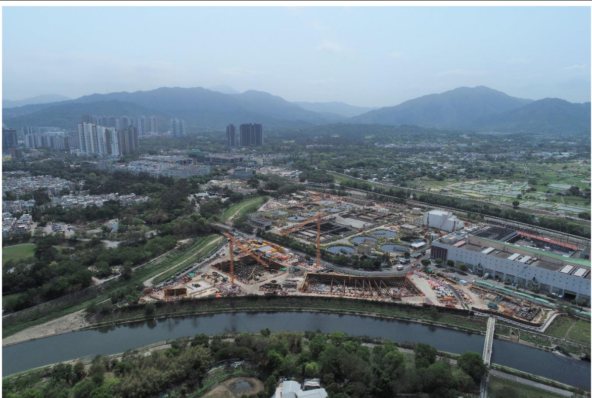
描述: 工地乙及丙部分的2號航拍照片 (拍攝於2021年3月11日)
