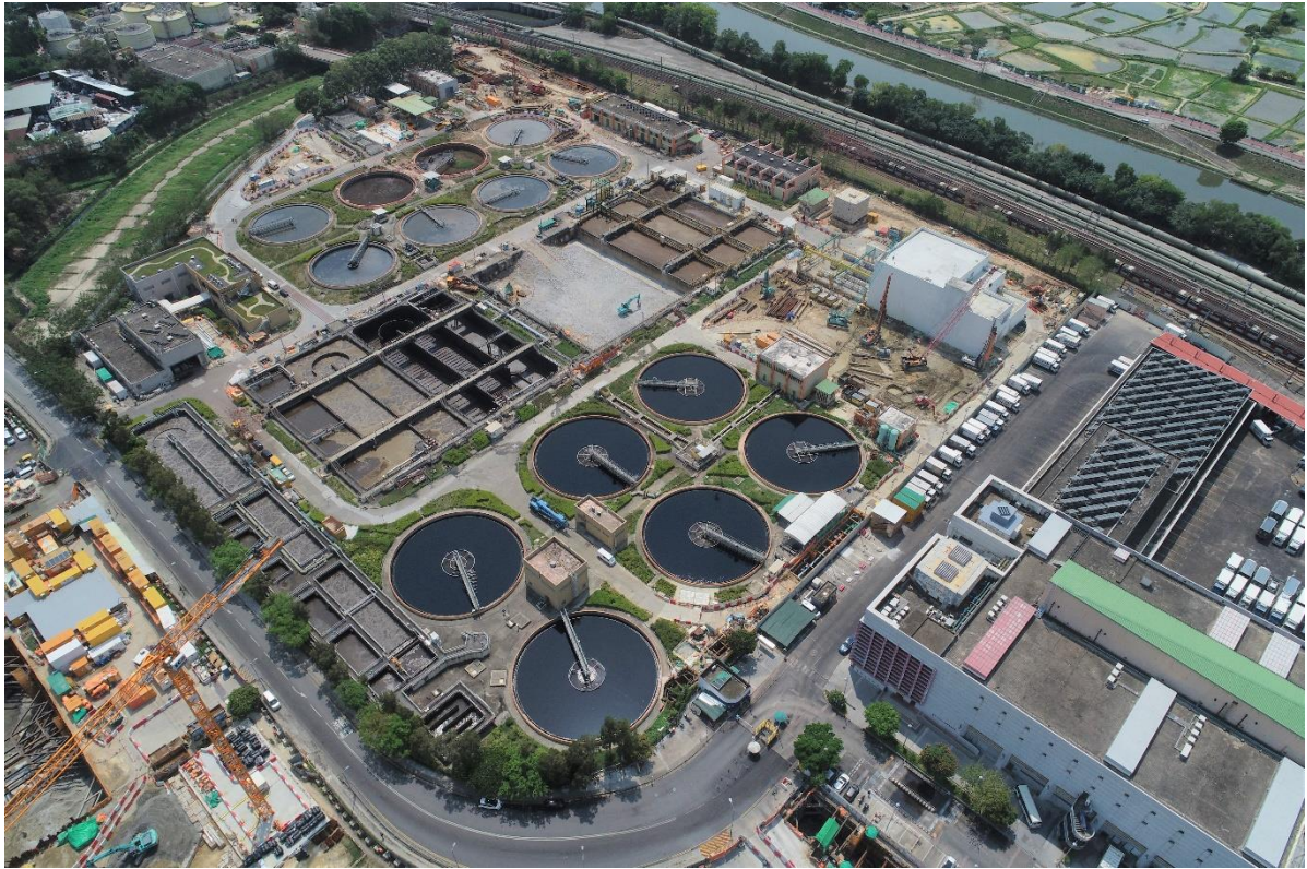
描述: 工地甲部分的1號航拍照片 (拍攝於2021年3月11日)
