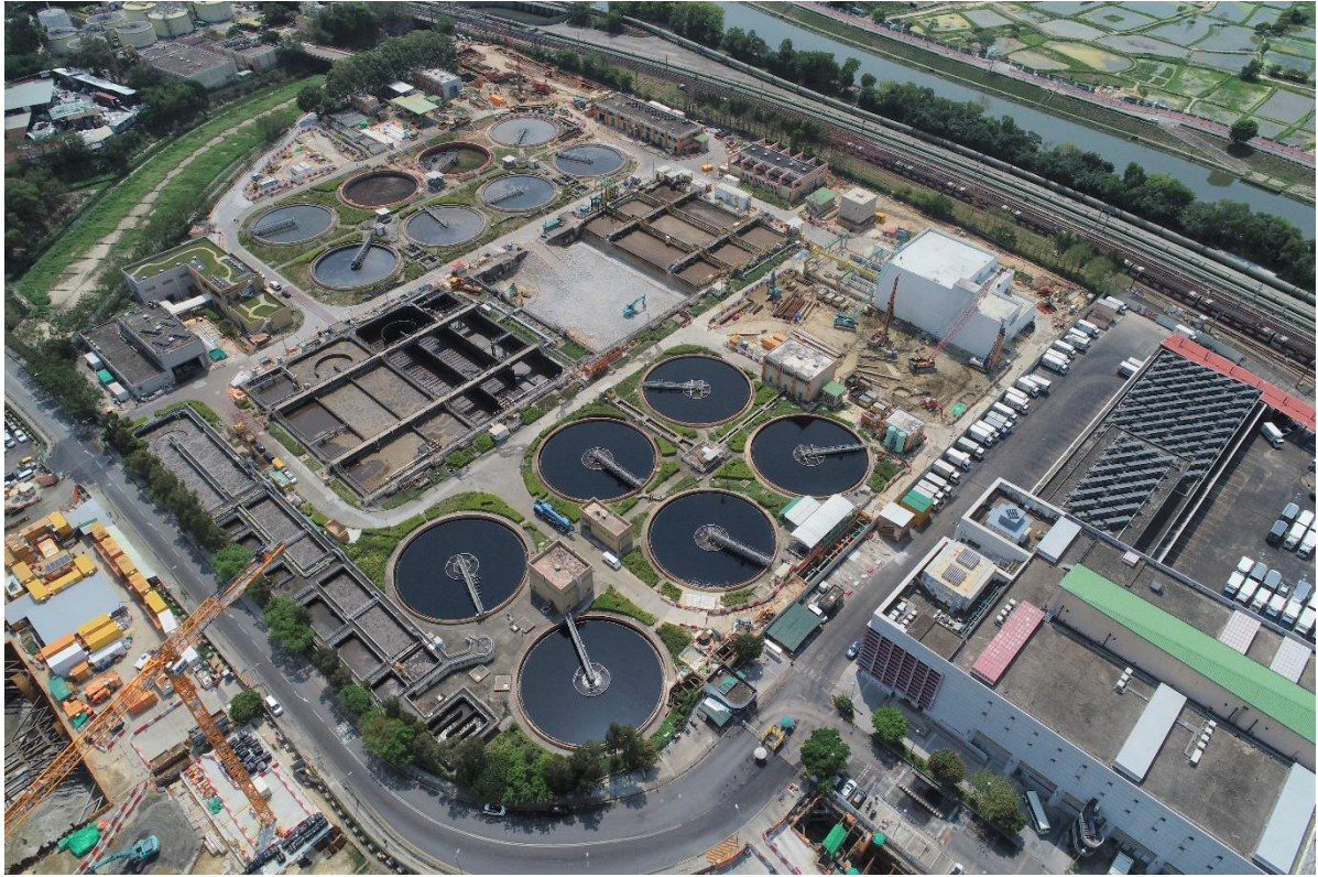
描述: 工地甲部分的1号航拍照片 (拍摄于2021年3月11日)
