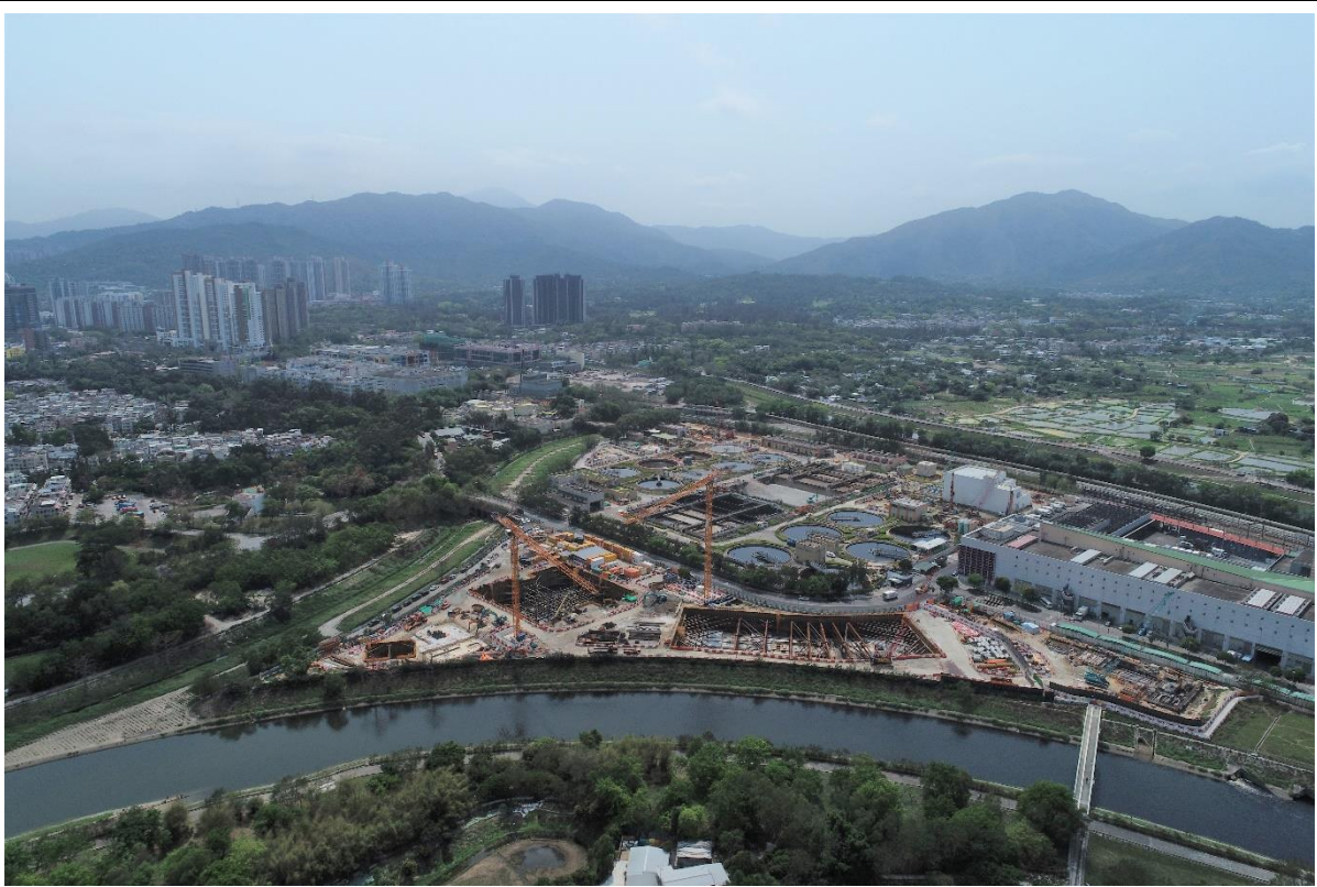
描述: 工地乙及丙部分的2号航拍照片 (拍摄于2021年3月11日)
