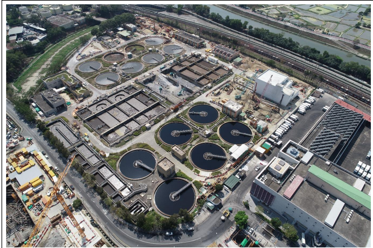
描述: 工地甲部分的1号航拍照片 (拍摄于2021年2月18日)
