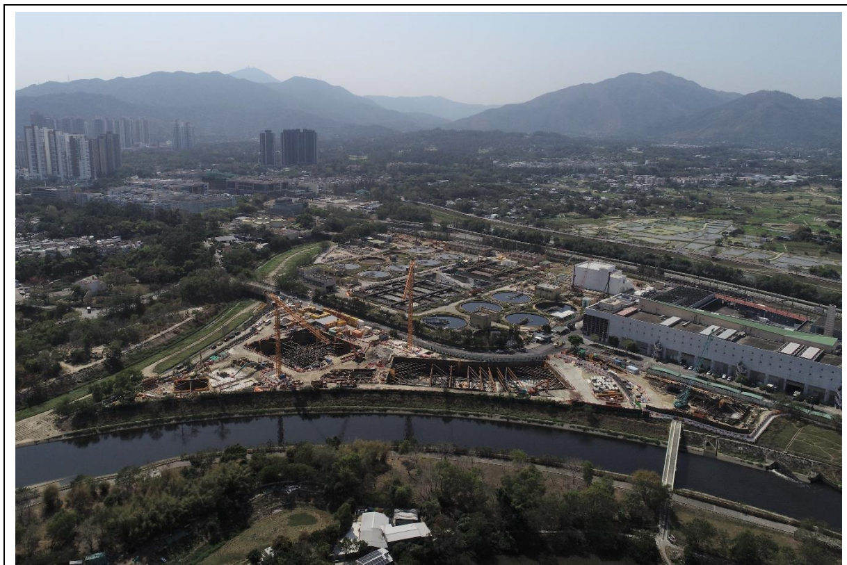
描述: 工地乙及丙部分的2号航拍照片 (拍摄于2021年2月18日)
