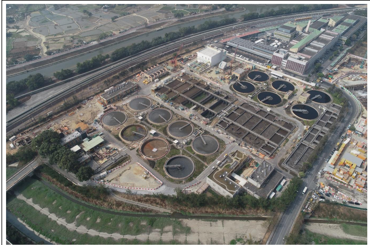
描述: 工地甲部分的1号航拍照片 (拍摄于2021年1月26日)
