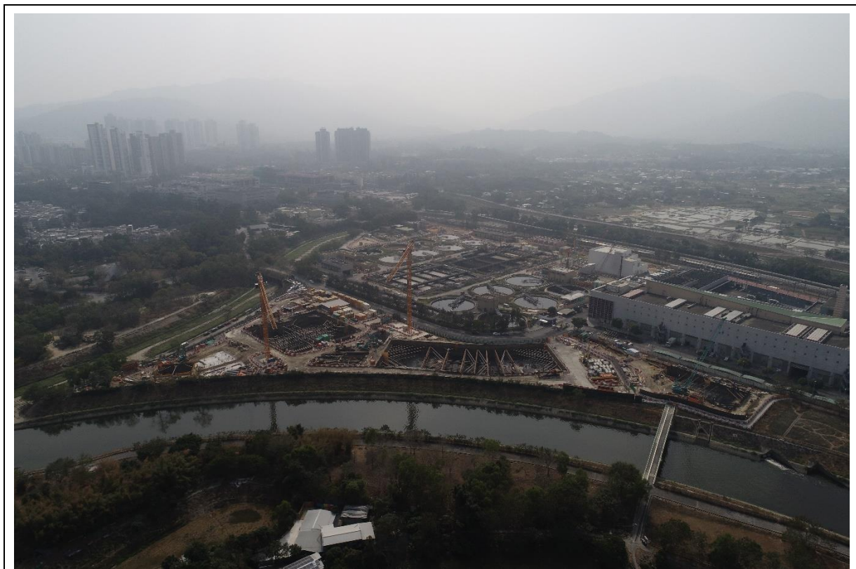
描述: 工地乙及丙部分的2号航拍照片 (拍摄于2021年1月26日)
