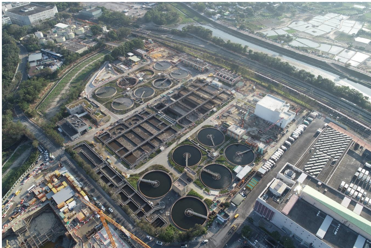
描述: 工地甲部分的1號航拍照片 (拍攝於2020年12月28日)
