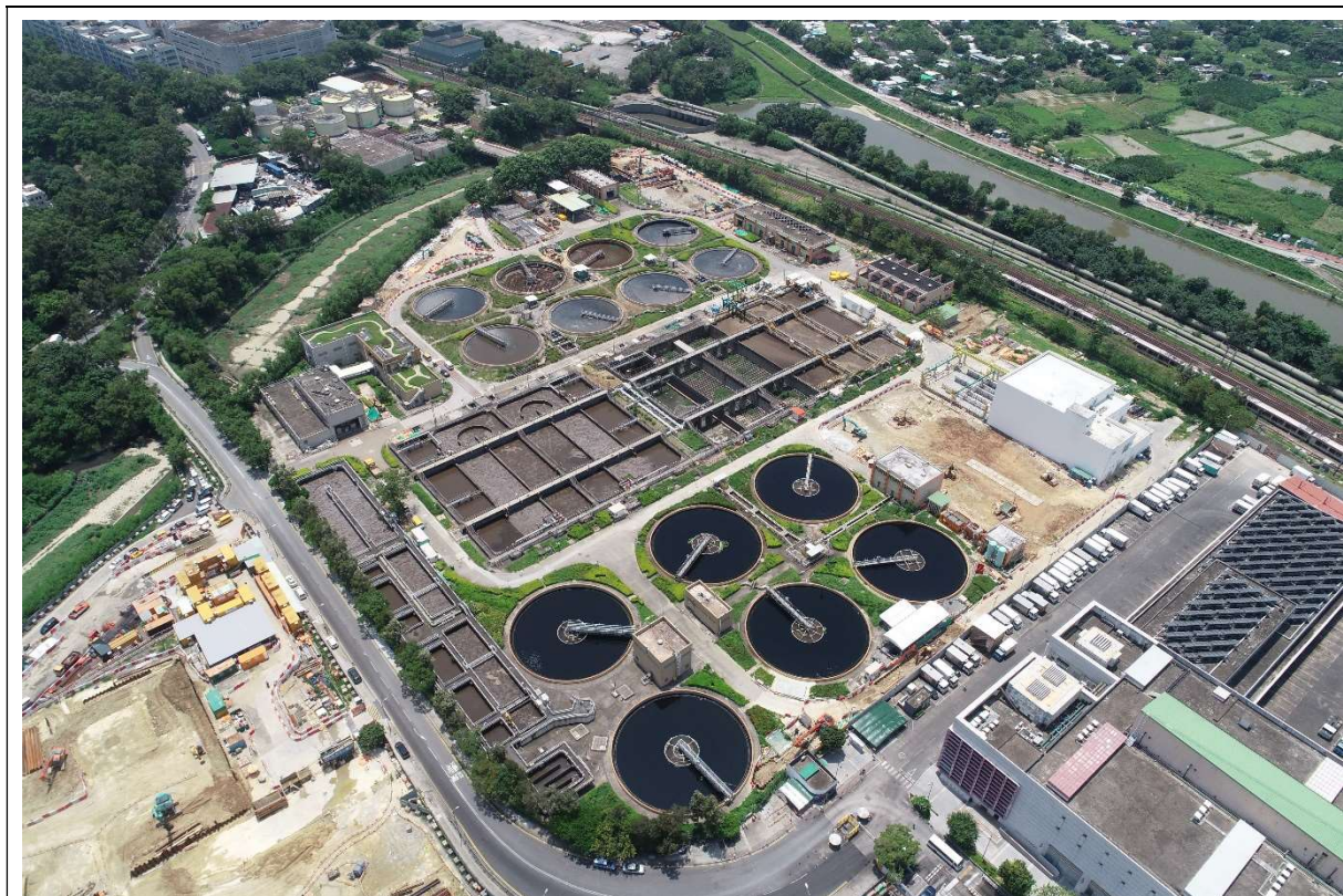
描述: 工地甲部分的1号航拍照片 (拍摄于2020年8月24日)
