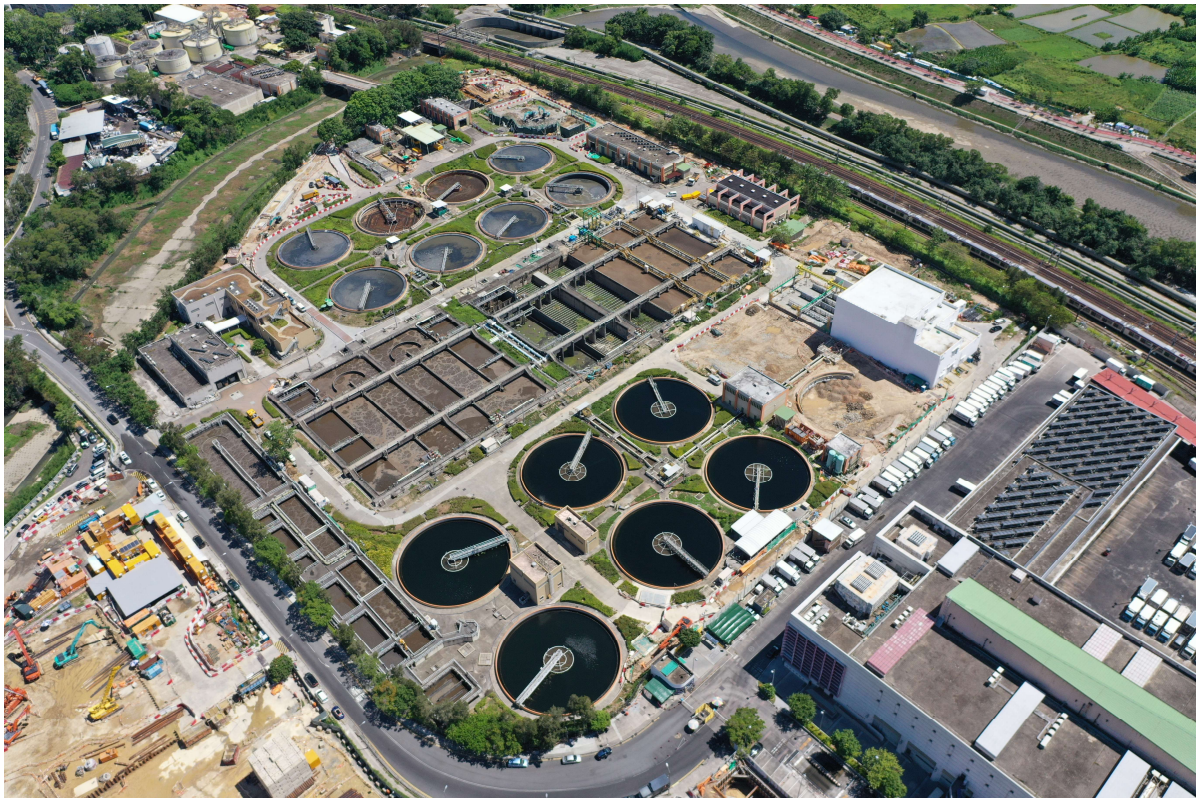
述: 工地甲部分及乙部分的1號航拍照片 (拍攝於2020年07月30日)
