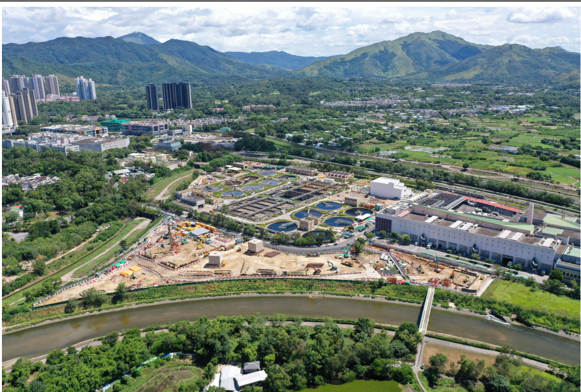
描述: 工地丙部分的1號航拍照片 (拍攝於2020年07月30日)
