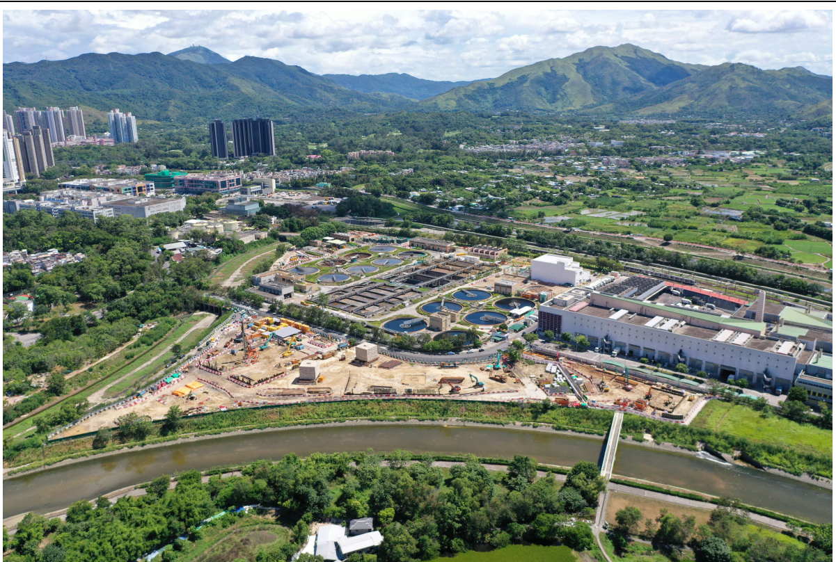
描述: 工地丙部分的1号航拍照片 (拍摄于2020年07月30日)
