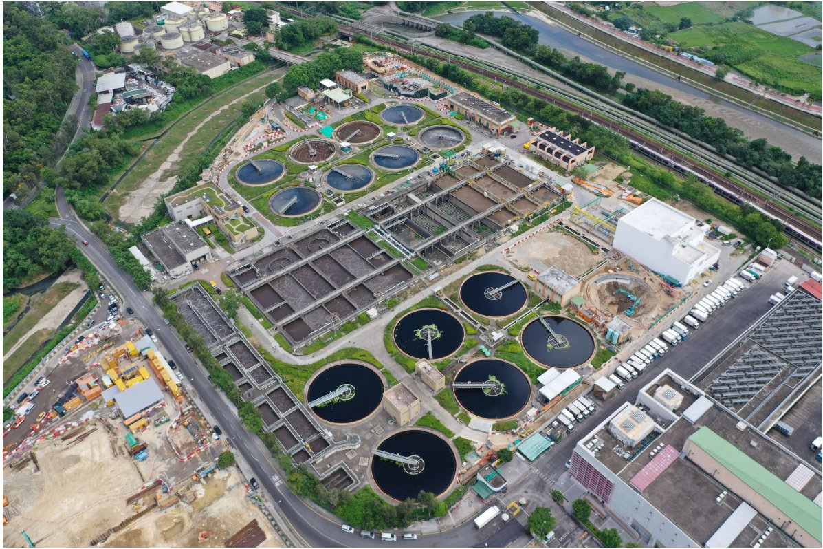
述: 工地甲部分及乙部分的1號航拍照片 (拍攝於2020年06月30日)
