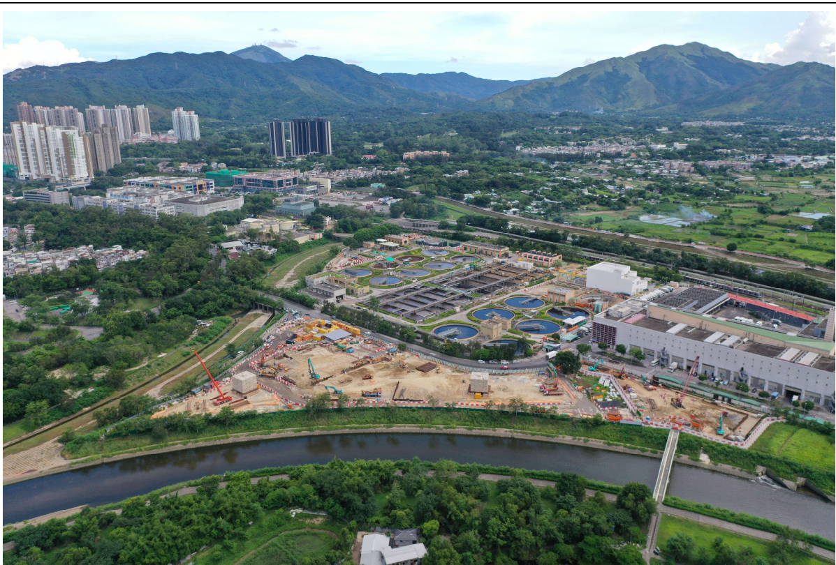
描述: 工地丙部分的1號航拍照片 (拍攝於2020年06月30日)
