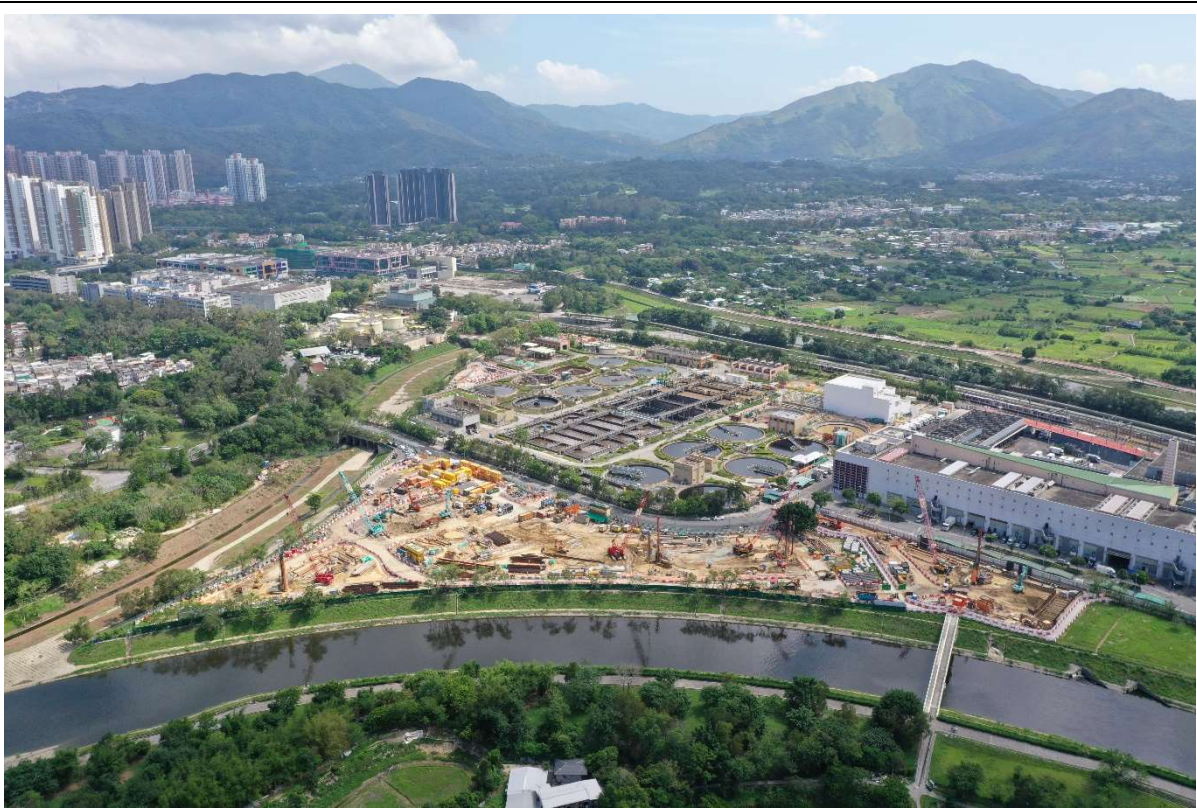
描述: 工地丙部分的1号航拍照片 (拍摄于2020年06月30日)
