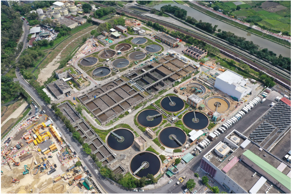
描述: 工地甲部分及乙部分的1號航拍照片 (拍攝於2020年05月15日)
