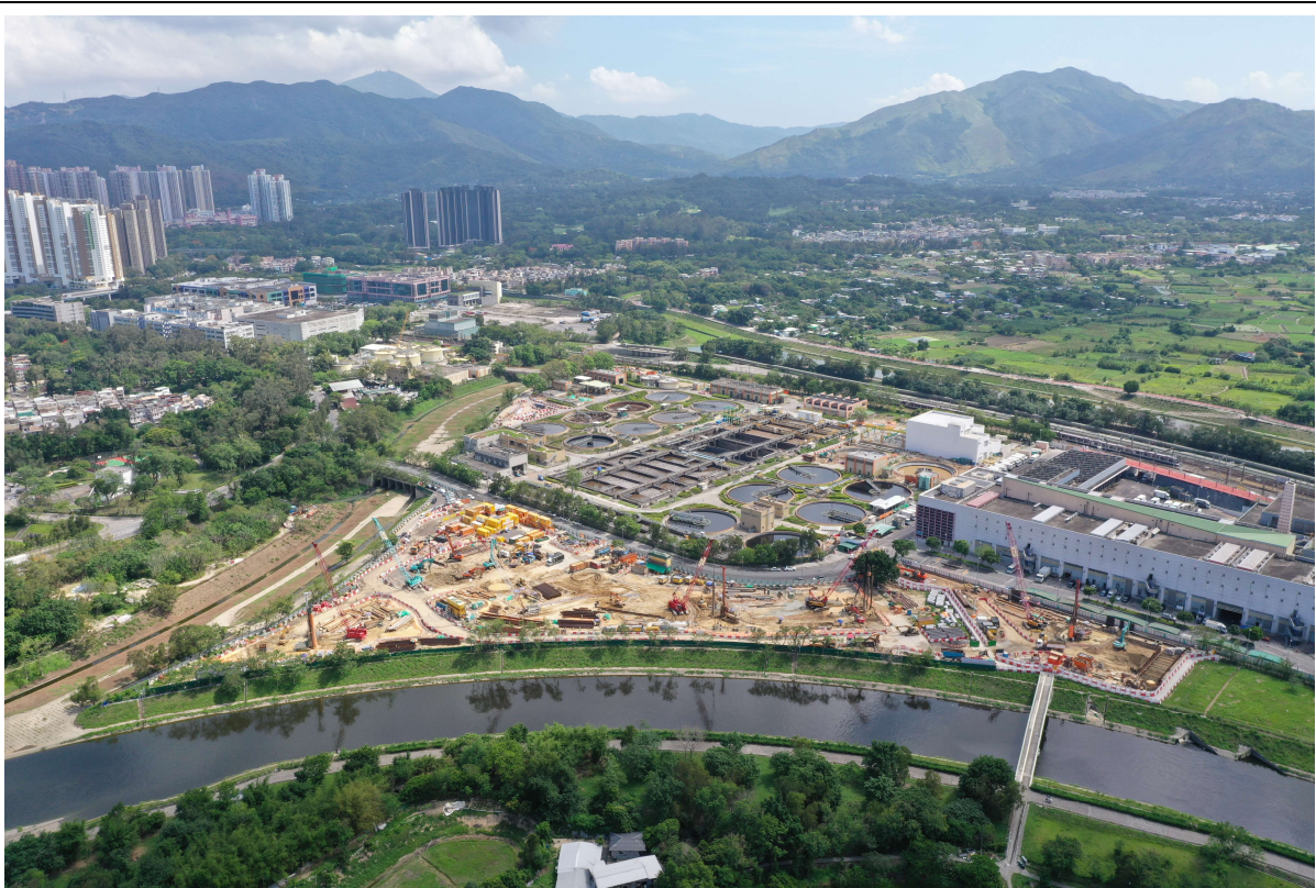
描述: 工地丙部分的1號航拍照片 (拍攝於2020年05月15日)
