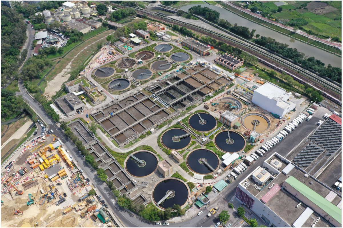
描述: 工地甲部分及乙部分的1号航拍照片 (拍摄于2020年05月15日)
