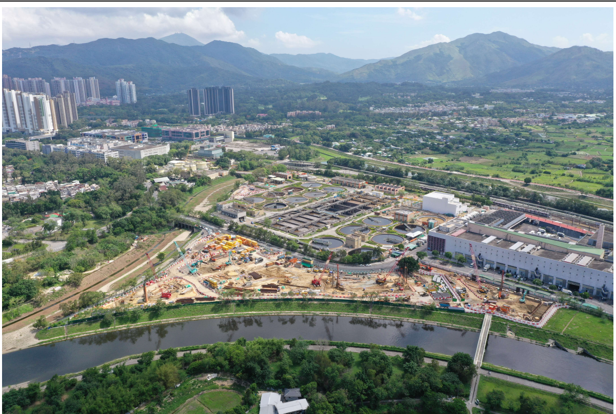
描述: 工地丙部分的1号航拍照片 (拍摄于2020年05月15日)
