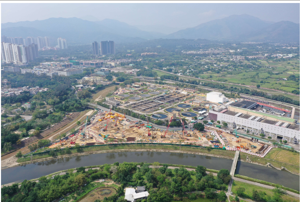
描述: 工地丙部分的1号航拍照片 (拍摄于2020年04月27日)
