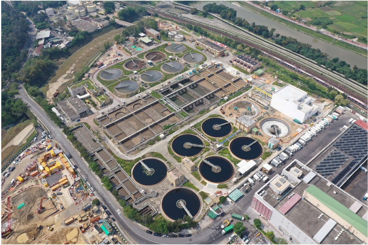
描述: 工地甲部分及乙部分的1号航拍照片 (拍摄于2020年04月27日)
