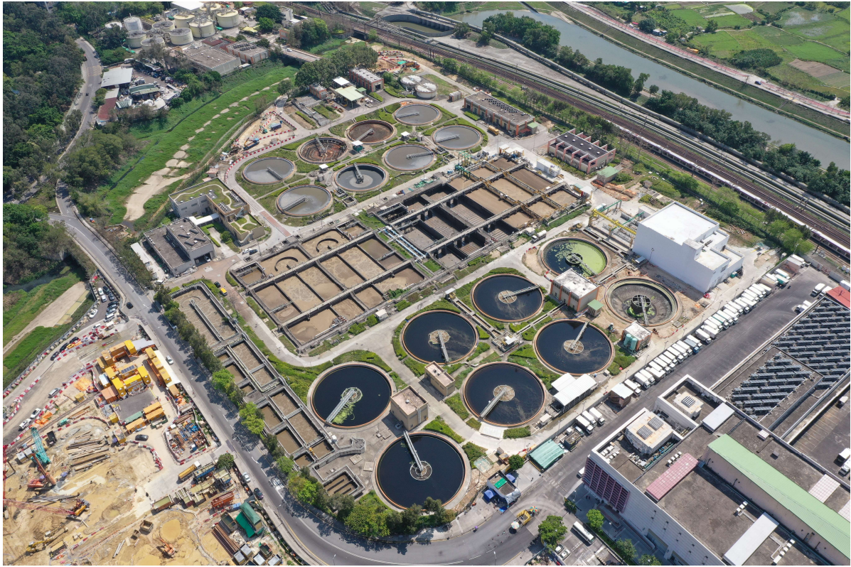
描述: 工地甲部分及乙部分的1號航拍照片 (拍攝於2020年03月25日)
