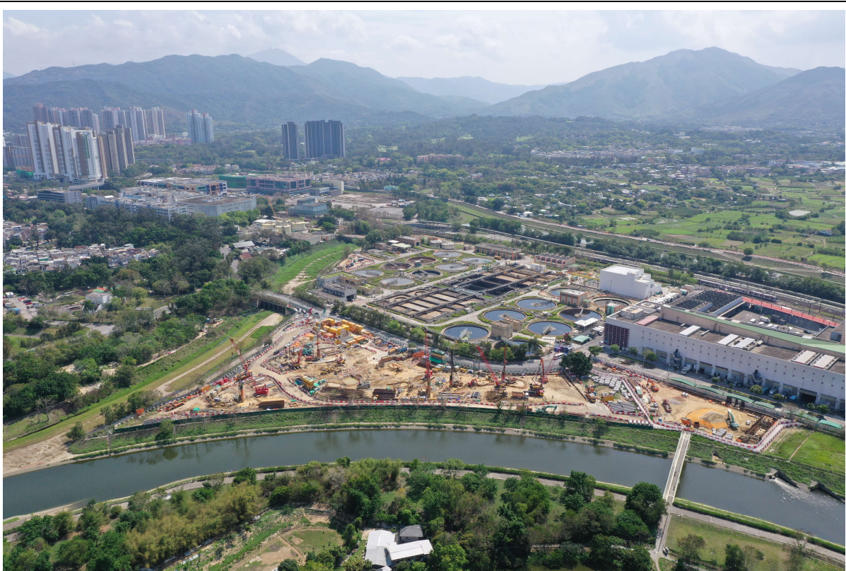
描述: 工地丙部分的1號航拍照片 (拍攝於2020年03月25日)
