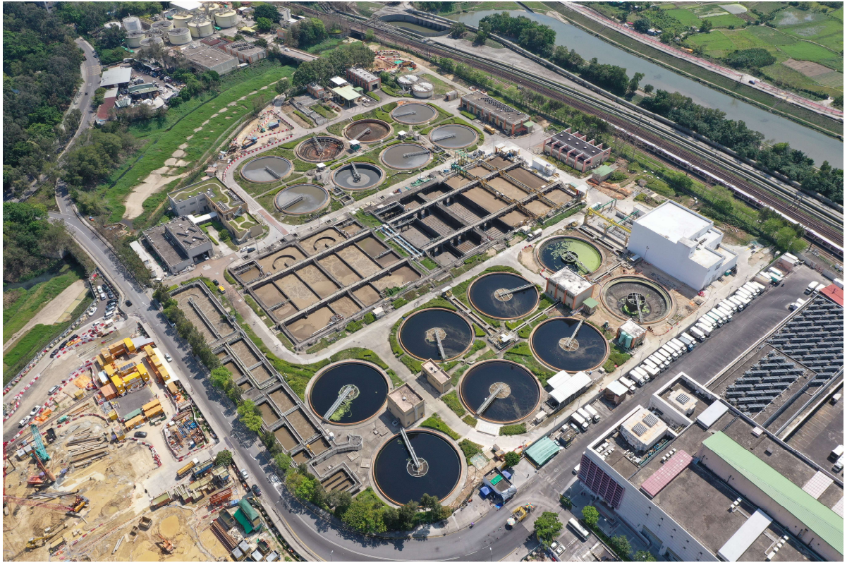
描述: 工地甲部分及乙部分的1号航拍照片 (拍摄于2020年03月25日)
