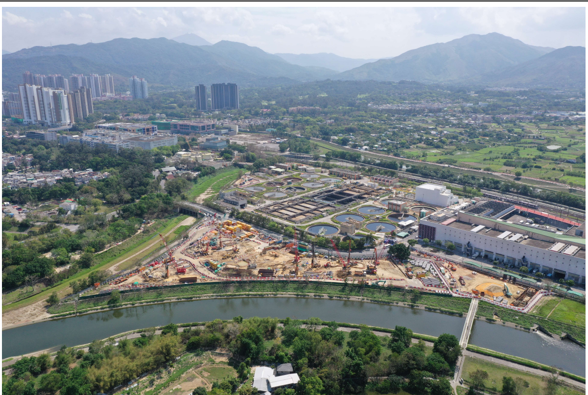
描述: 工地丙部分的1号航拍照片 (拍摄于2020年03月25日)
