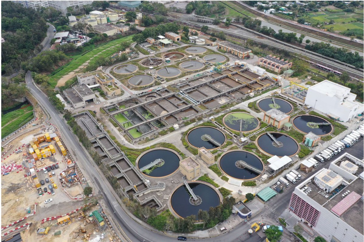
描述: 工地甲部分及乙部分的1號航拍照片 (拍攝於2020年01月17日)
