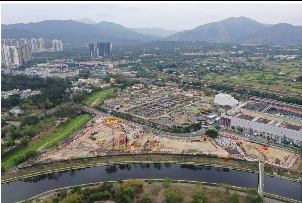
描述: 工地丙部分的1號航拍照片 (拍攝於2020年01月17日)
