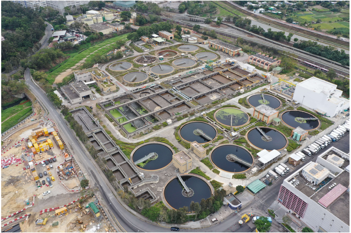
描述: 工地甲部分及乙部分的1号航拍照片 (拍摄于2020年01月17日)
