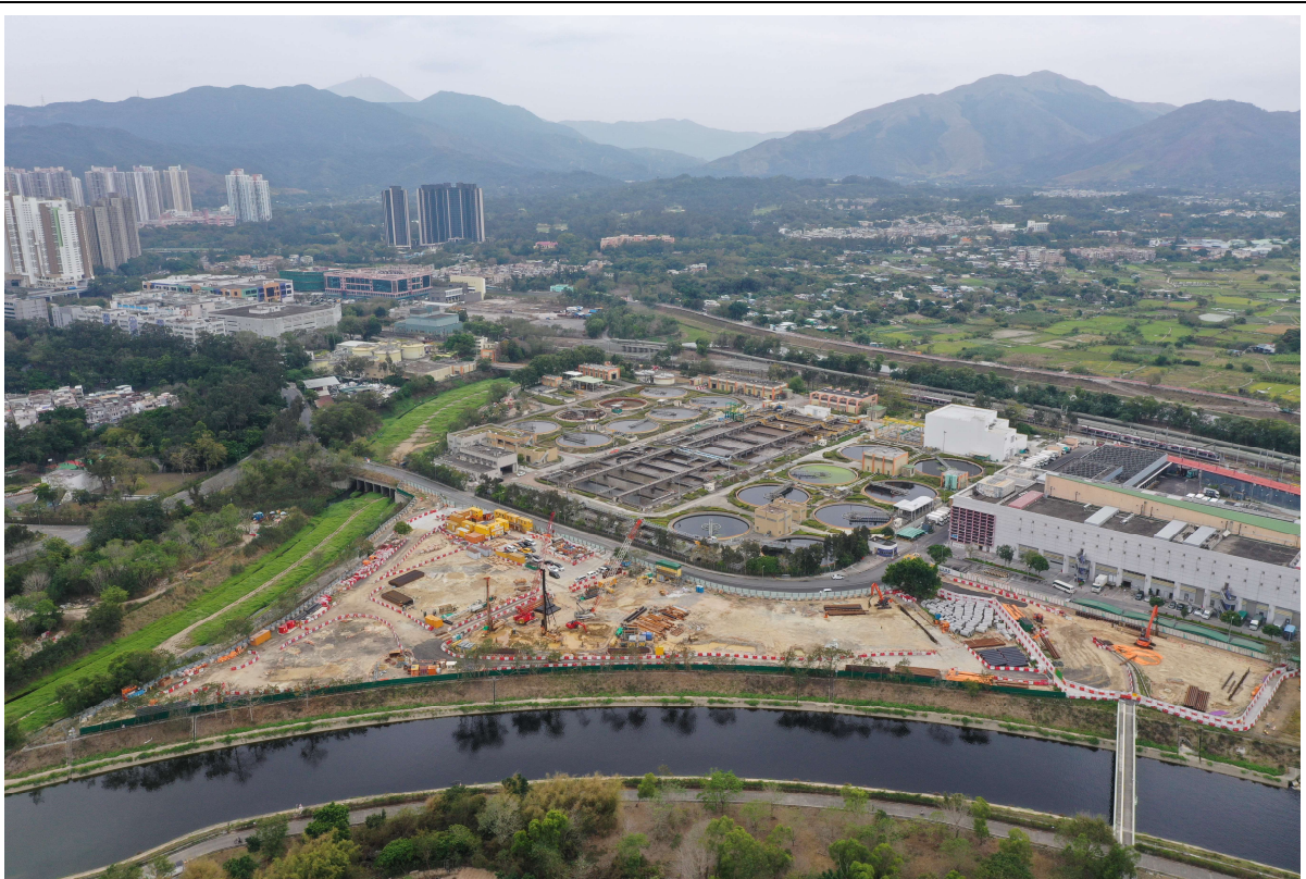
描述: 工地丙部分的1号航拍照片 (拍摄于2020年01月17日)
