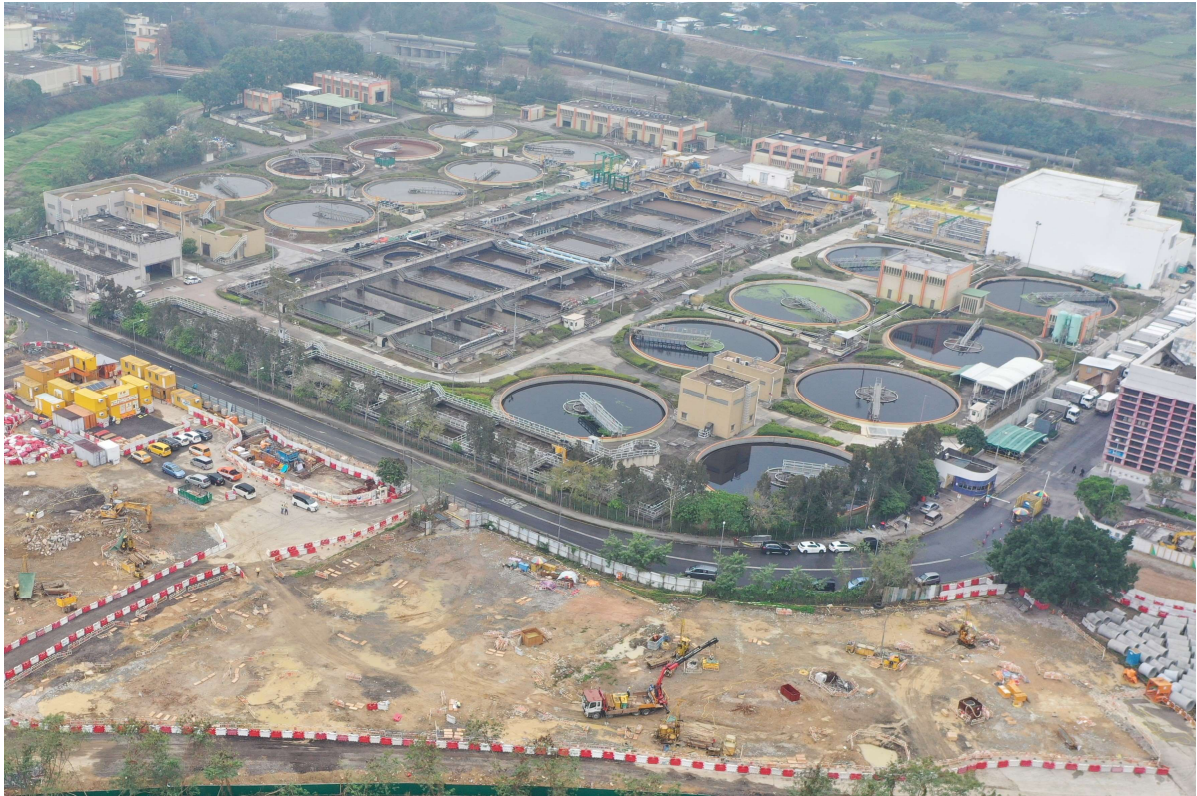
描述: 工地甲部分及乙部分的1號航拍照片 (拍攝於2019年12月31日)
