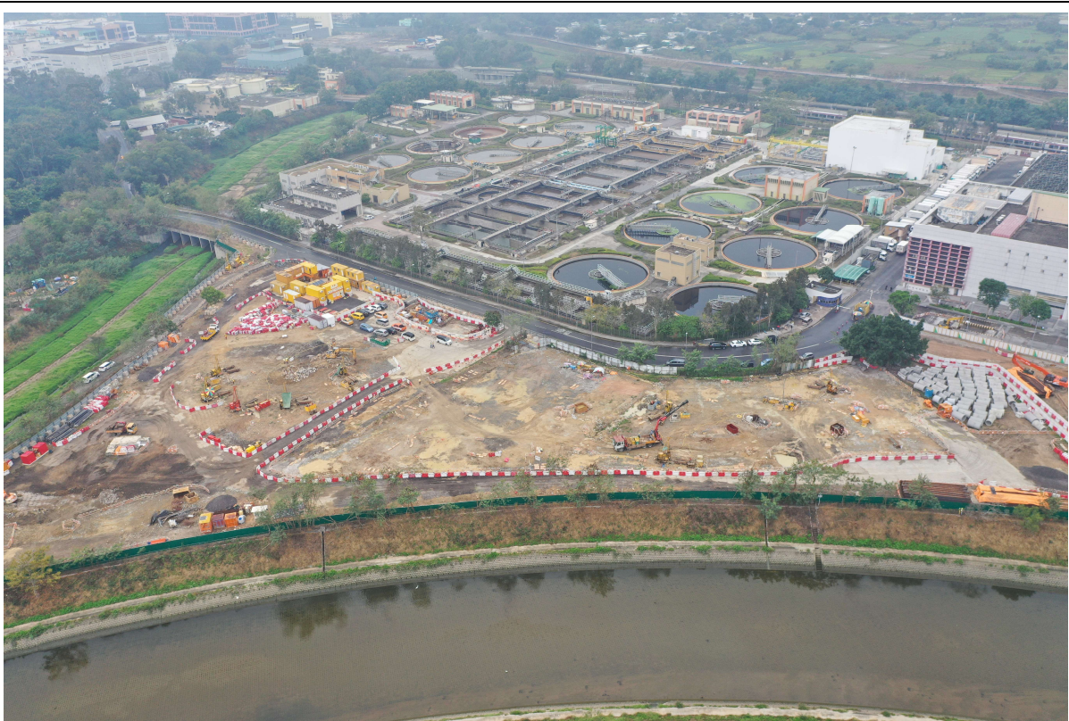
描述: 工地丙部分的1號航拍照片 (拍攝於2019年12月31日)
