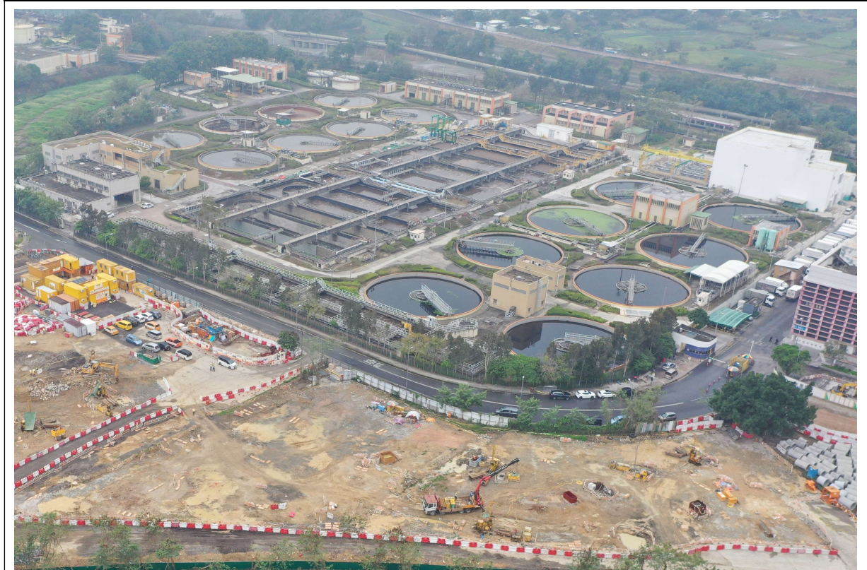
描述: 工地甲部分及乙部分的1号航拍照片 (拍摄于2019年12月31日)
