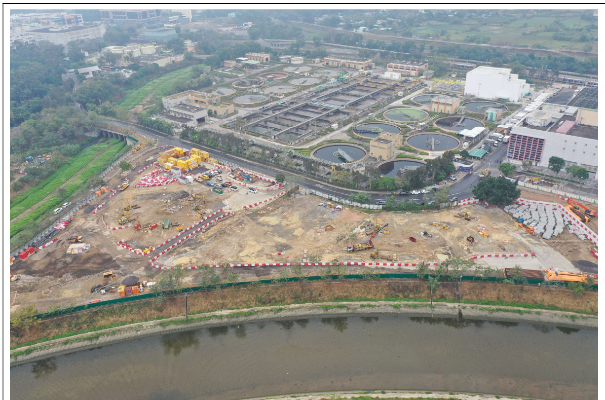
描述: 工地丙部分的1号航拍照片 (拍摄于2019年12月31日)
