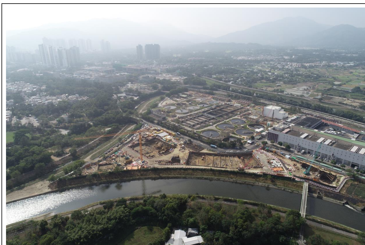
描述: 工地乙及丙部分的2號航拍照片 (拍攝於2020年11月26日)
