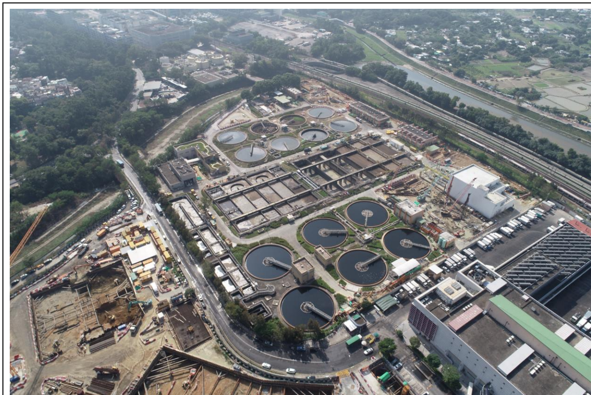
描述: 工地甲部分的1號航拍照片 (拍攝於2020年11月26日)
