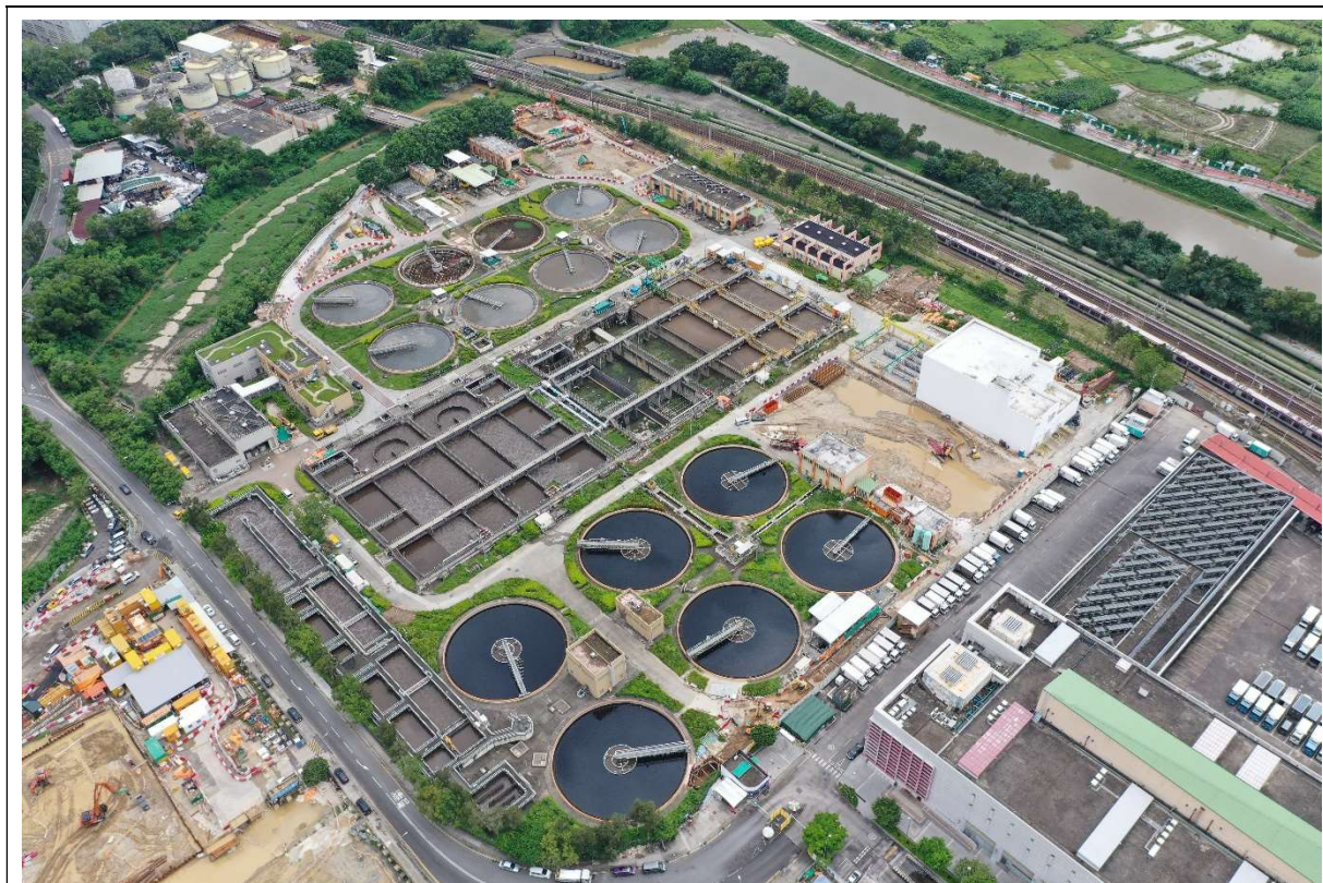
描述: 工地甲部分的1號航拍照片 (拍攝於2020年9月21日)
