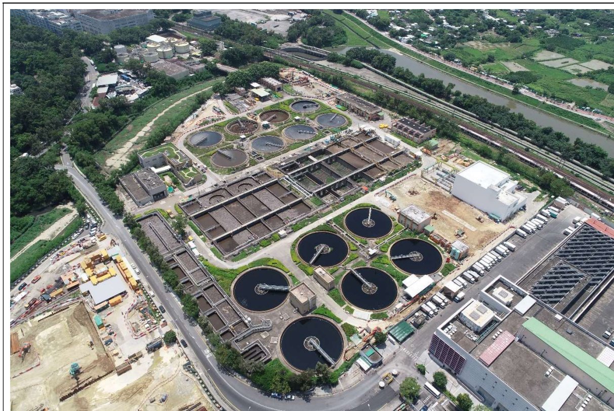
描述: 工地甲部分的1號航拍照片 (拍攝於2020年8月24日)
