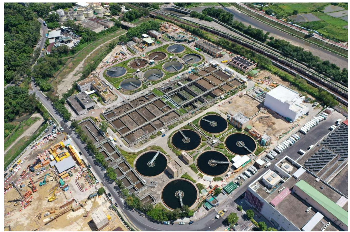
描述: 工地甲部分的1號航拍照片(拍攝於2020年7月30日)
