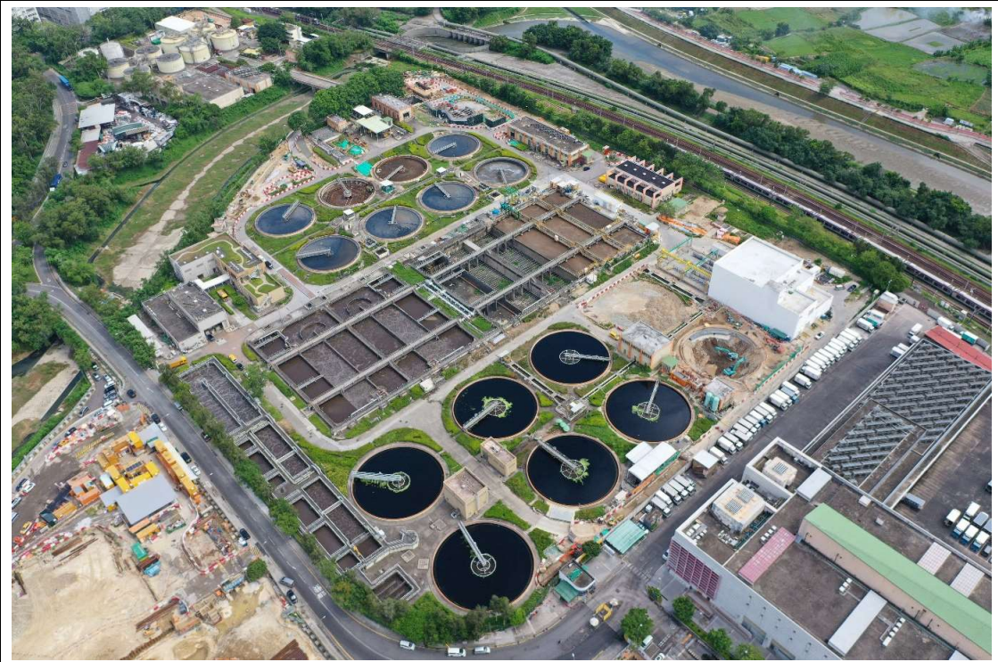
描述: 工地甲及乙部分的1號航拍照片(拍攝於2020年6月30日)
