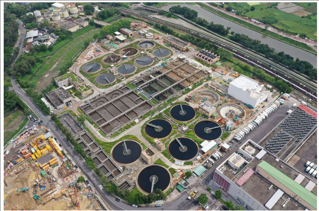
描述: 工地甲及乙部分的1號航拍照片(拍攝於2020年5月15日)
