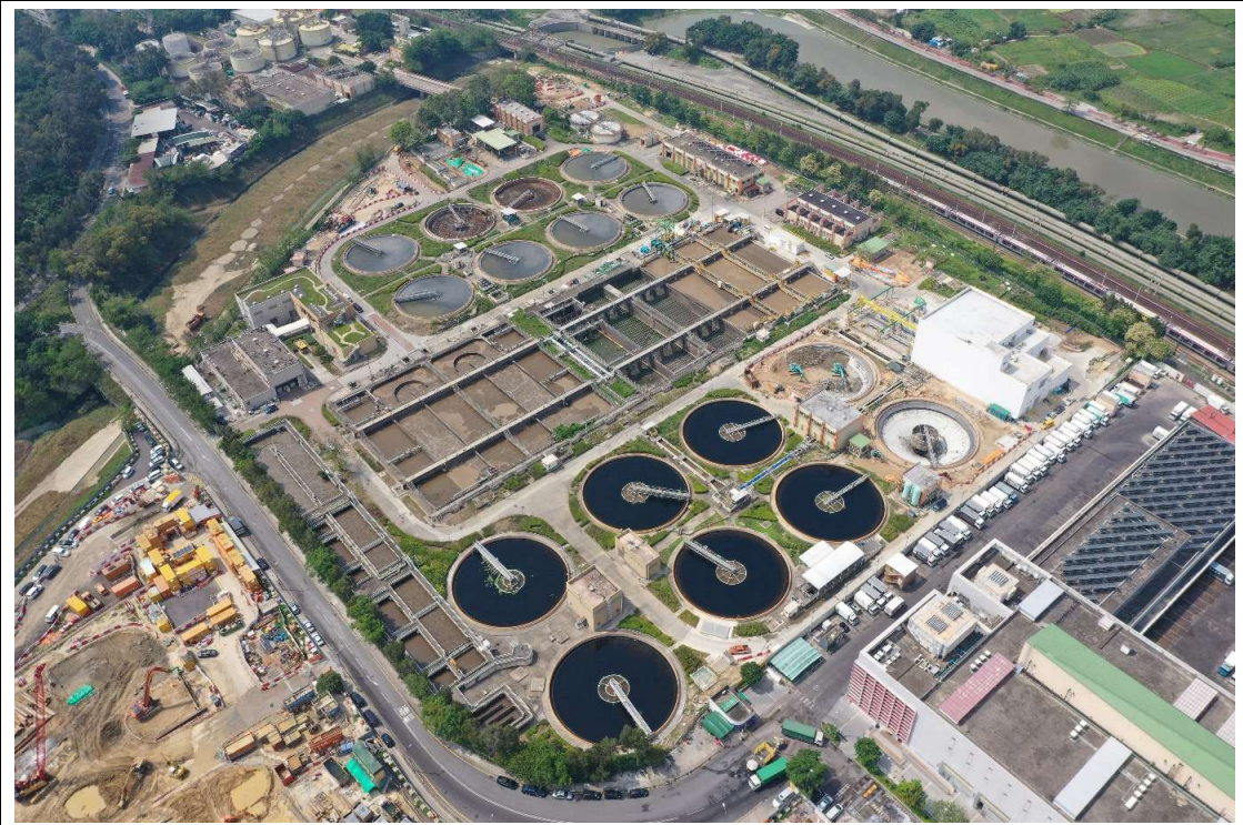
描述: 工地甲及乙部分的1號航拍照片(拍攝於2020年4月27日)
