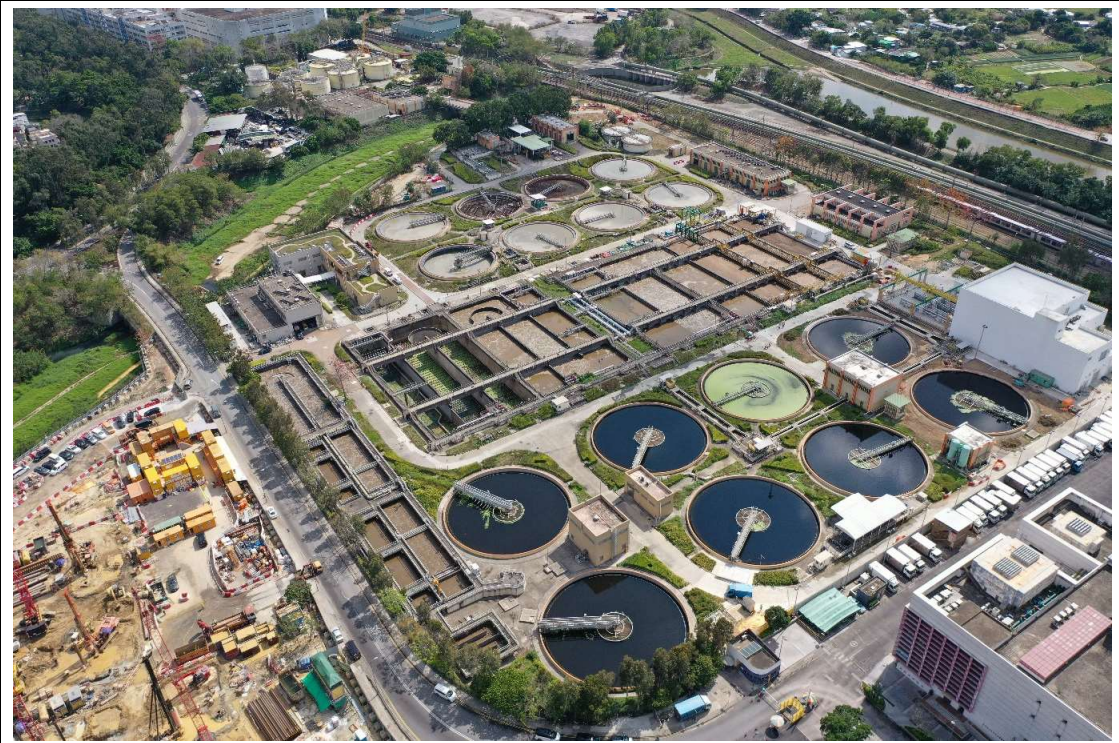
描述: 工地甲及乙部分的1號航拍照片(拍攝於2020年2月26日)
